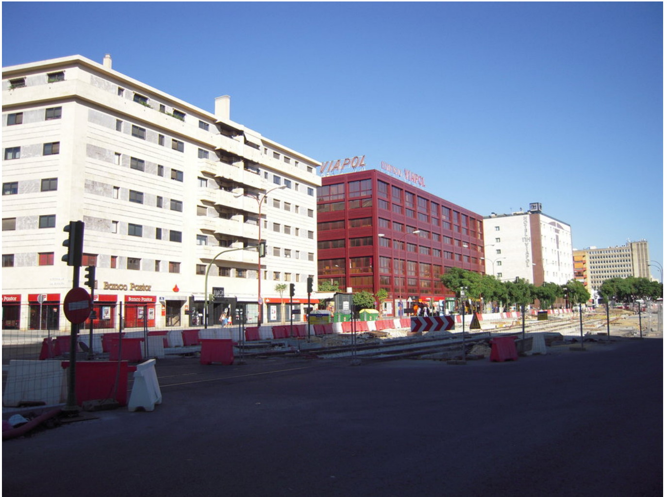
Výstavba prodloužení Metrocentra na snímcích z roku 2010
