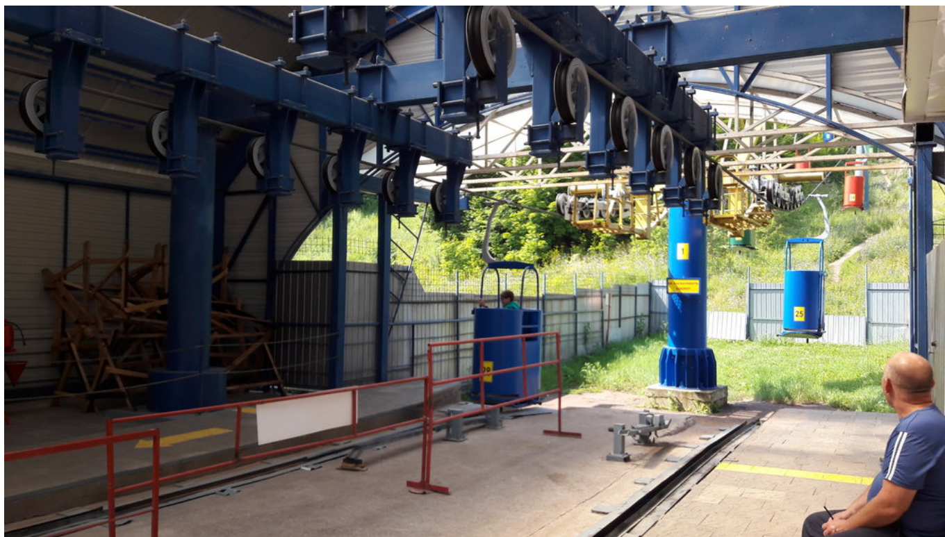
Spodní stanice lanové dráhy a okolí.
