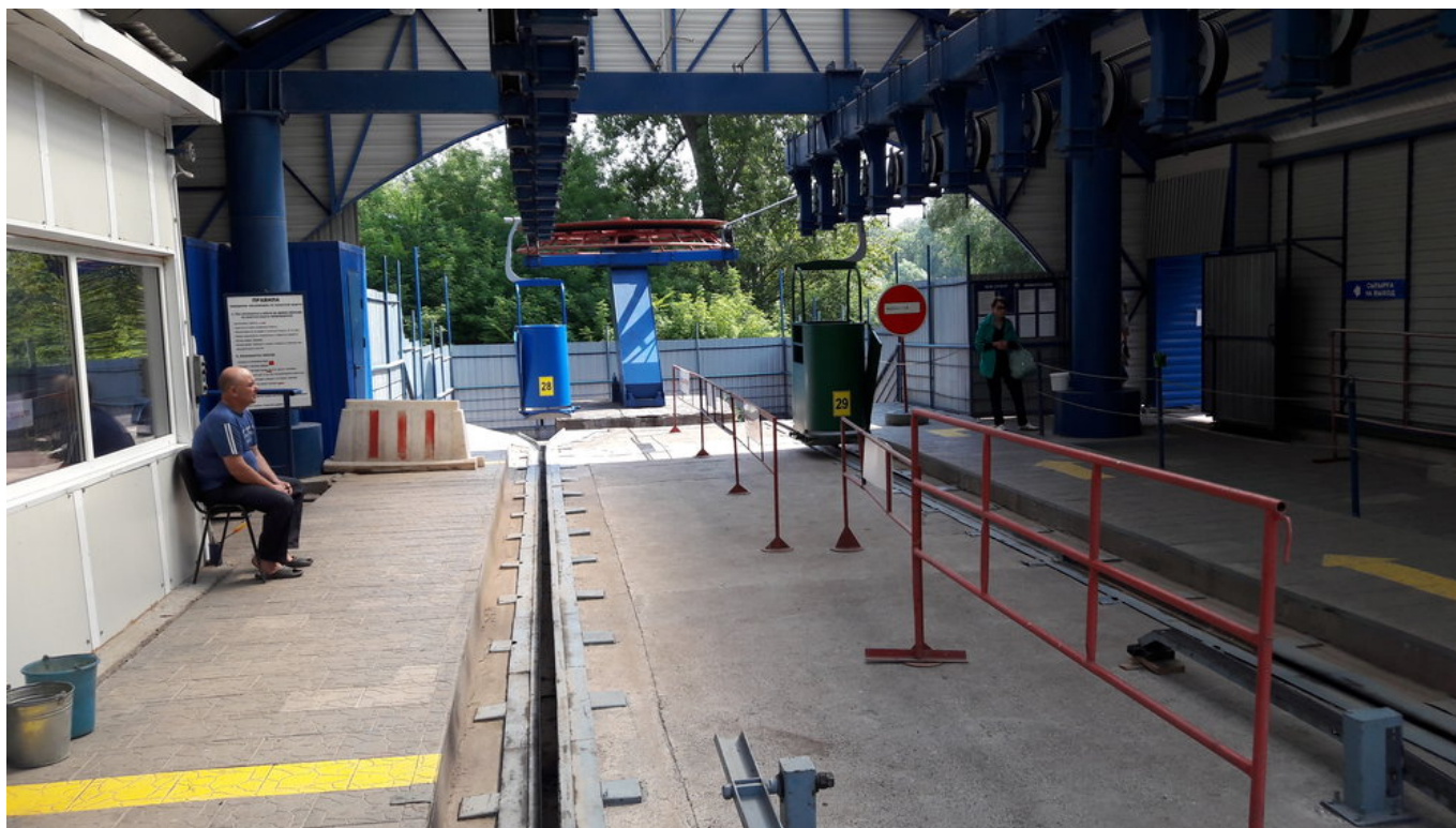
Spodní stanice lanové dráhy.
