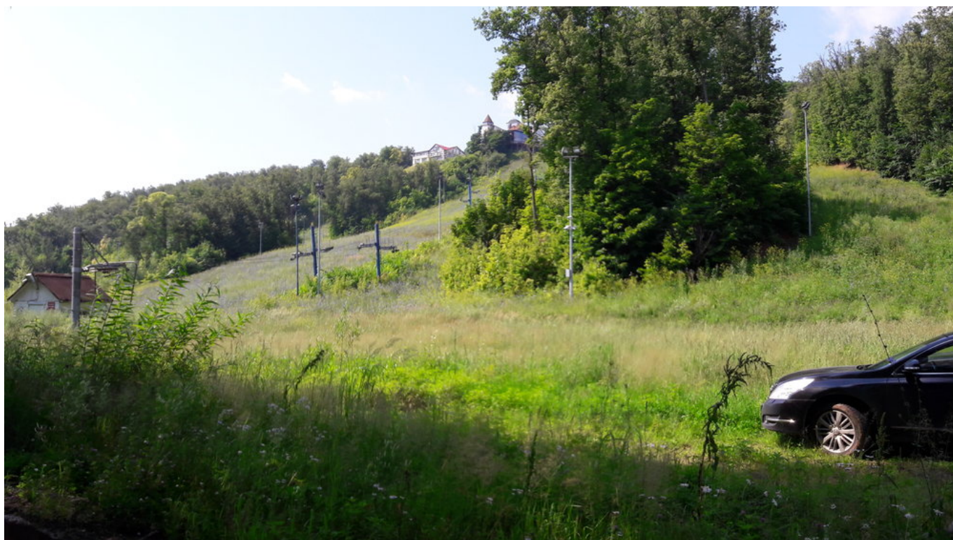
Spodní stanice lanové dráhy a okolí.
