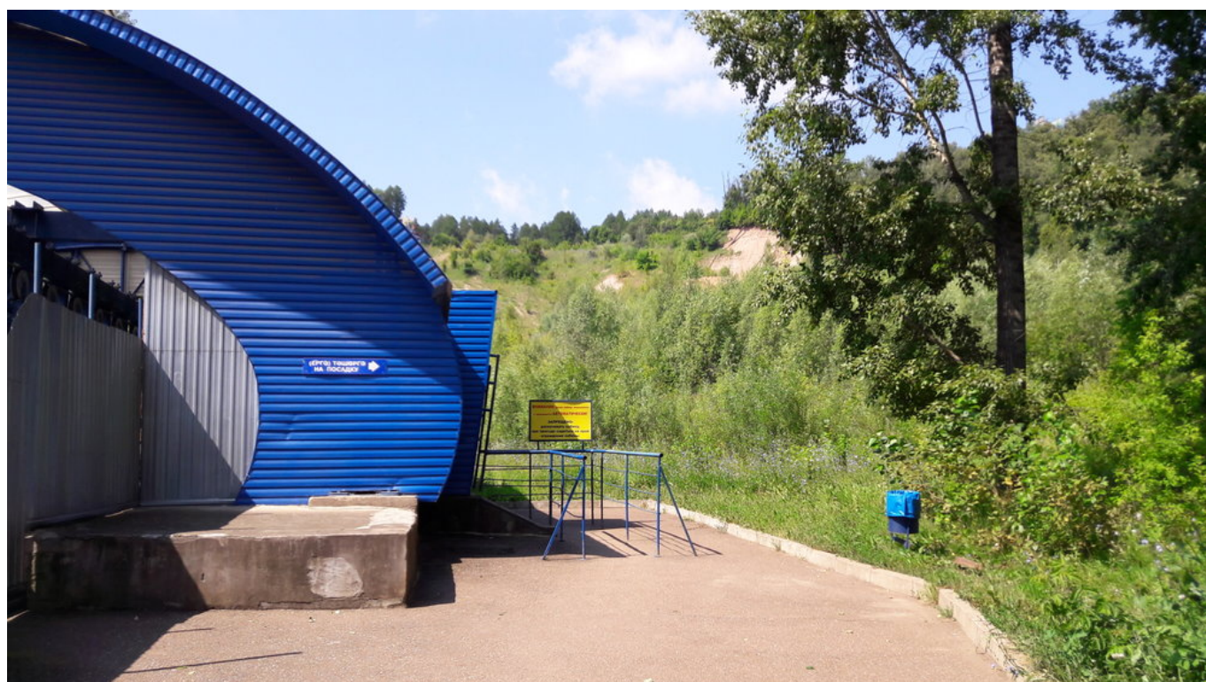
Spodní stanice lanové dráhy a okolí.
