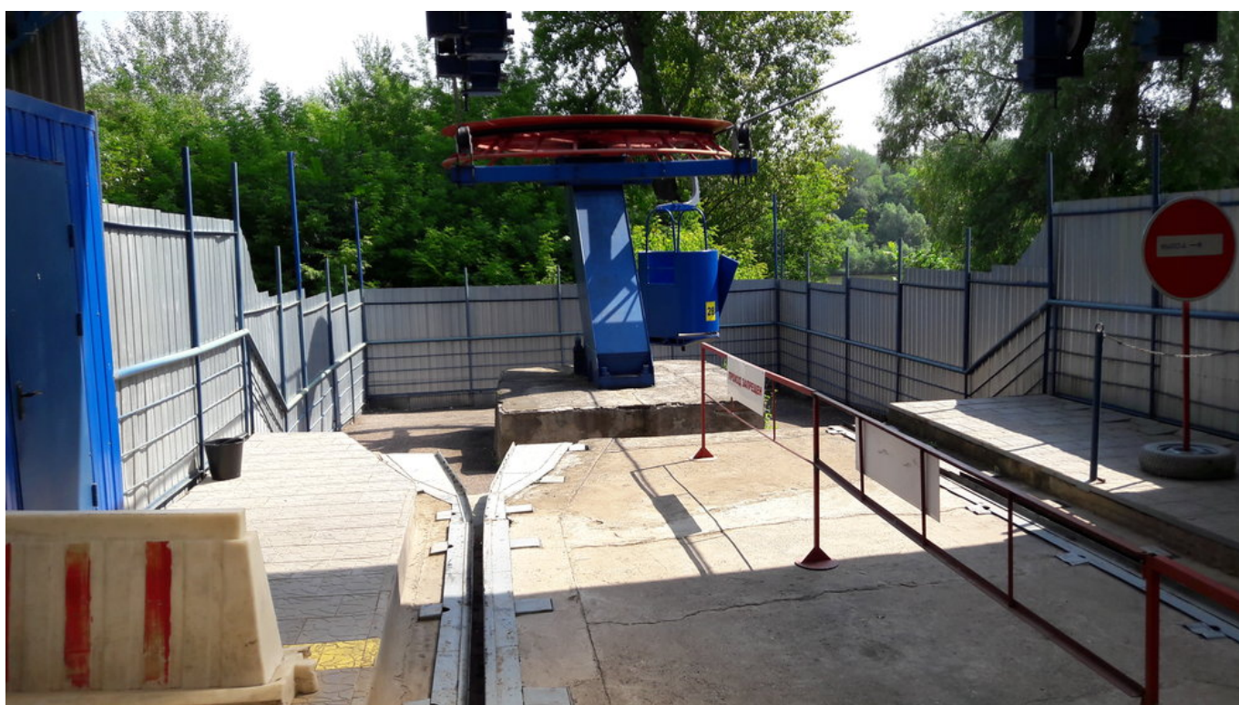
Spodní stanice lanové dráhy.
