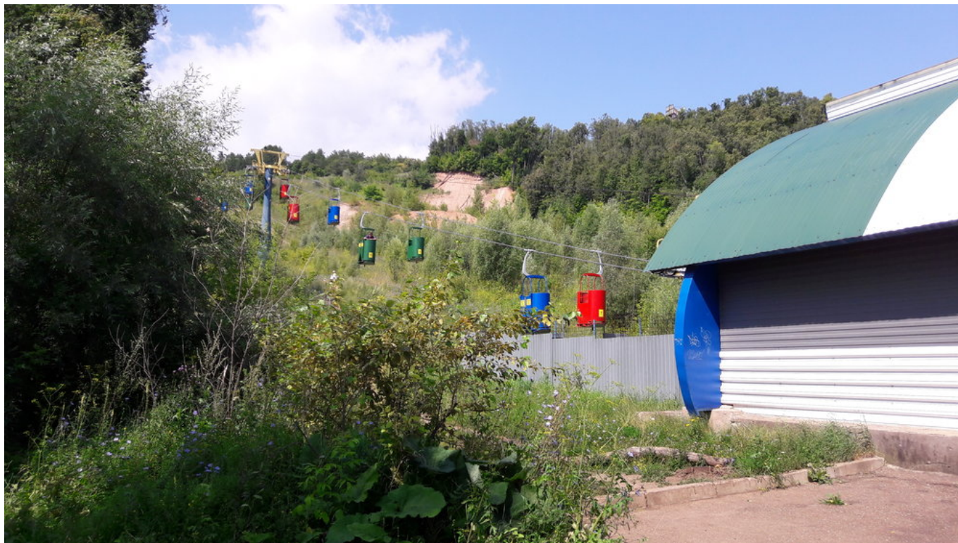
Spodní stanice lanové dráhy a okolí.
