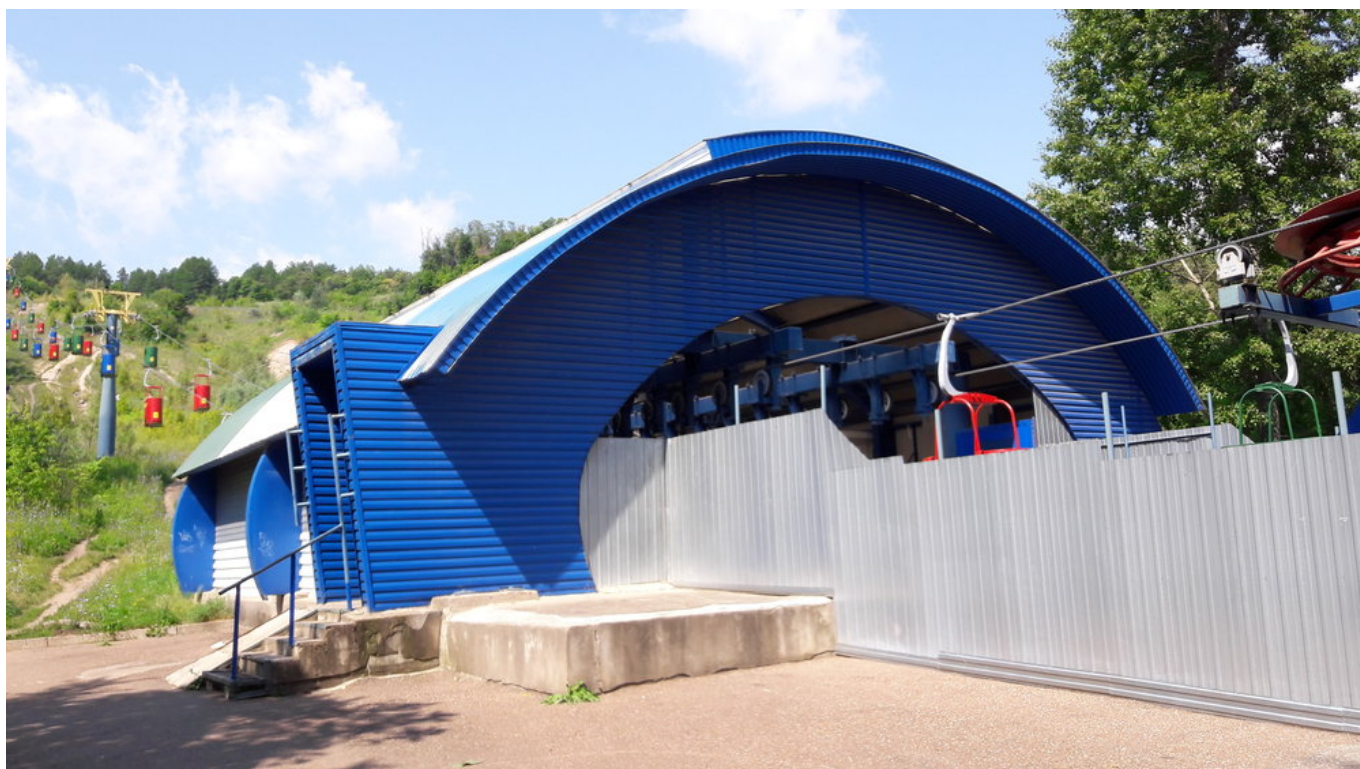
Spodní stanice lanové dráhy a okolí.
