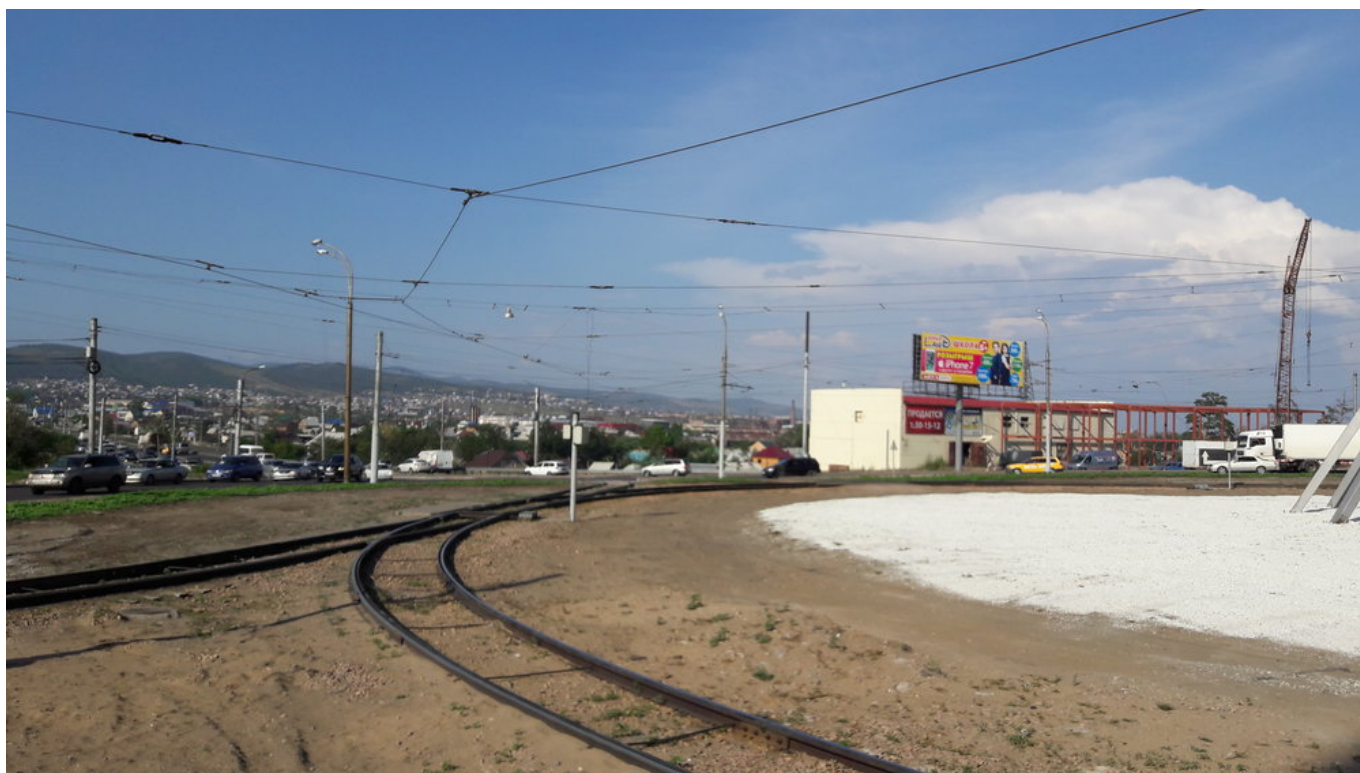
Kruhový objezd. Foceno směrem k severu, kudy se tramvaje přes Novyj most dostanou ke Strelke a pak zase do centra.
