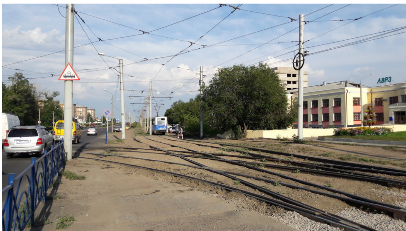
A ještě jednou místo, kde se trať k LVRZ napojuje na hlavní tramvajový okruh.
