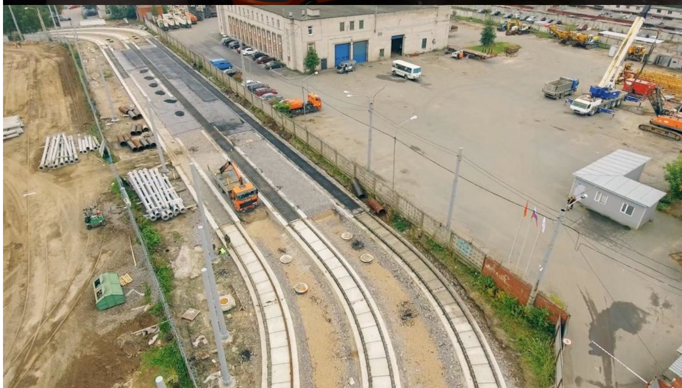
Pohled na areál u ulice Chasanskoj loni během stavby. (foto: Čížik / TKK)
