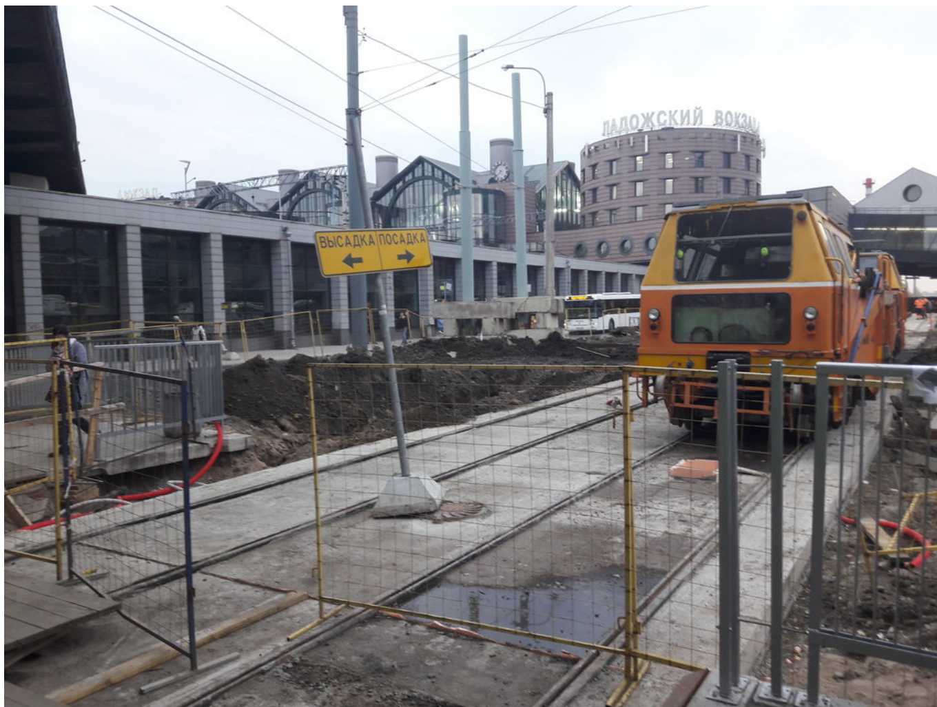
U stanice metra Ladožskaja vzniká velký přestupní terminál.
