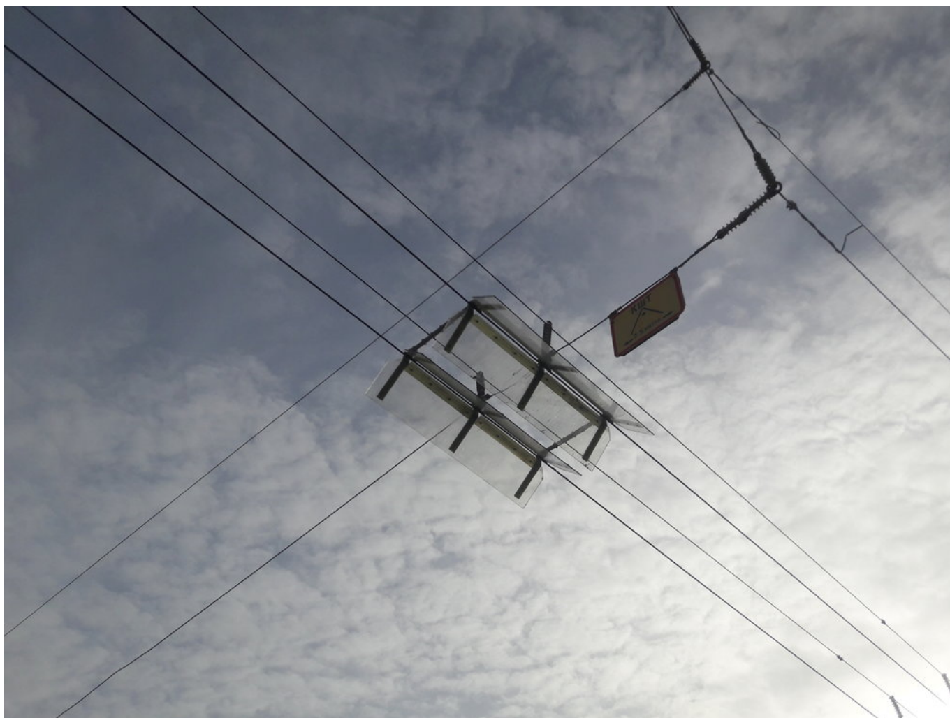
Natrolejovací stříšky.
