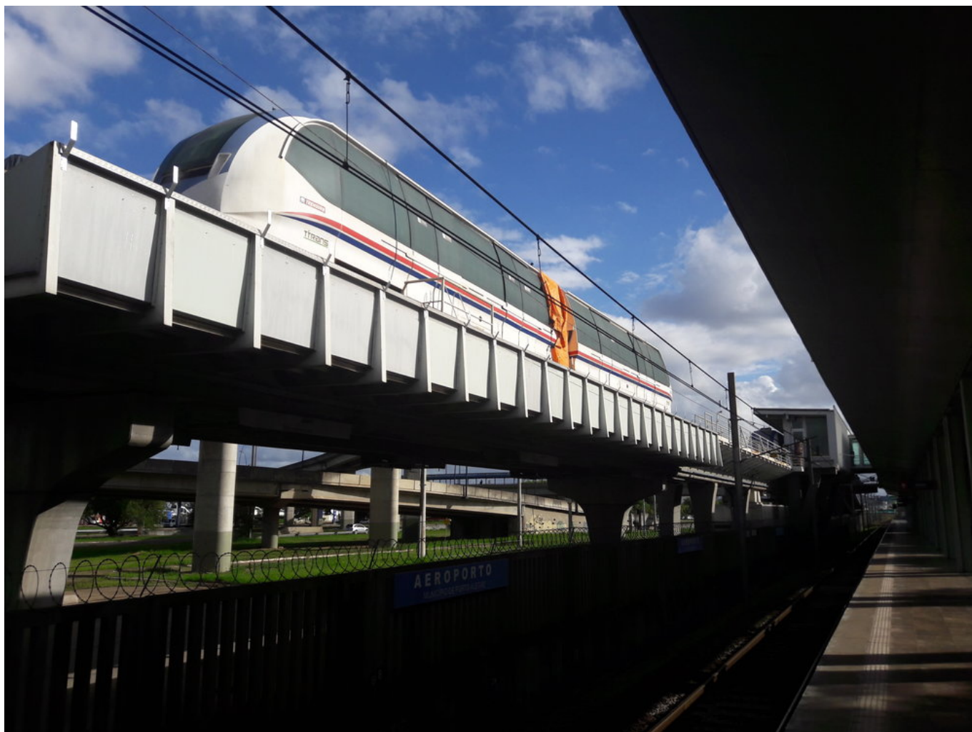
Výchozí stanice aeromóvelu Aeroporto s nástupištěm stejnojmenné stanice metra.
