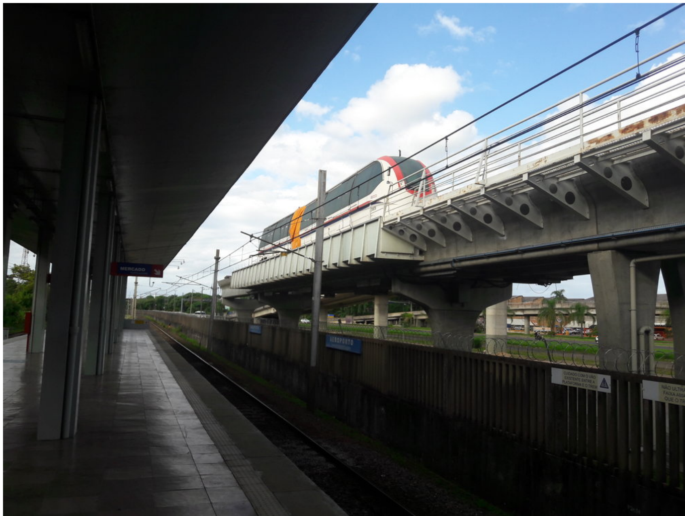
Stanice Aeroporto s nefunkční dvouvozovou jednotkou.
