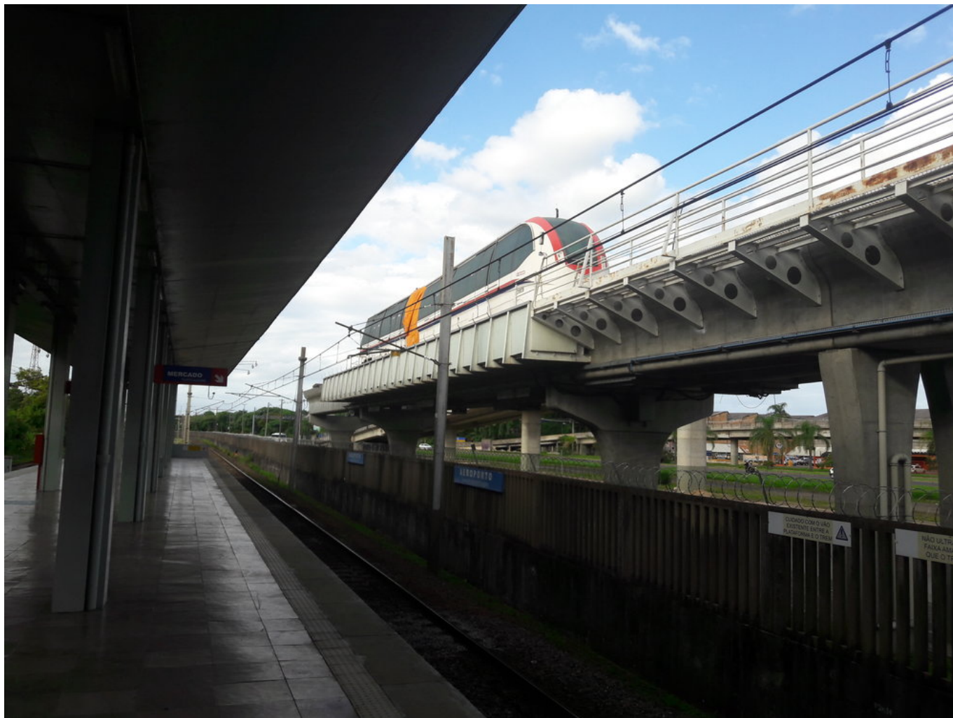
Stanice Aeroporto s nefunkční dvouvozovou jednotkou.
