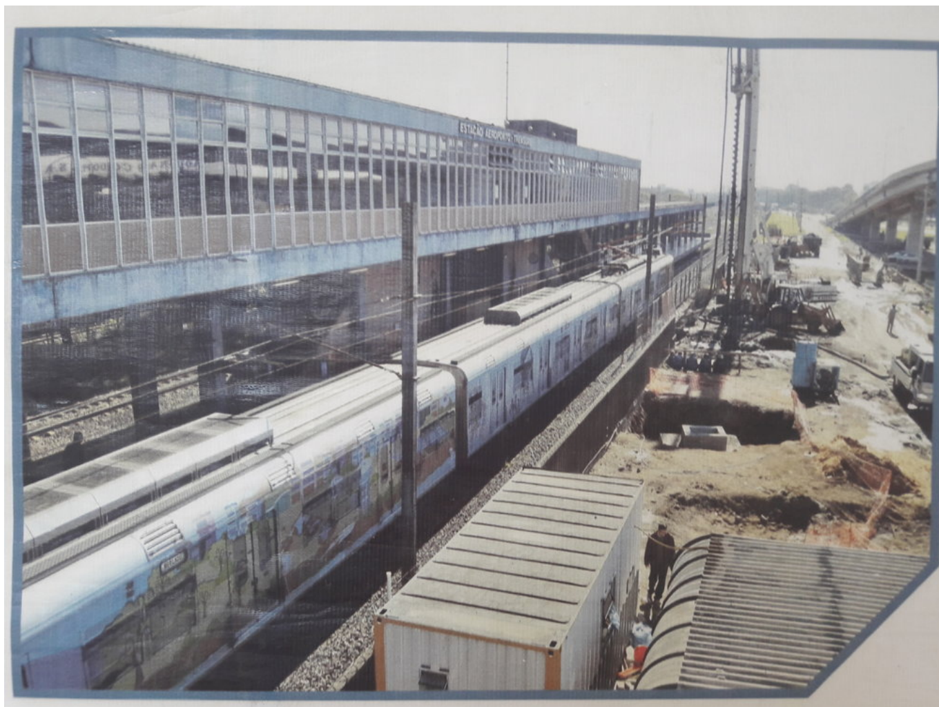
Výstavba aeromóvelu v tomto století.
