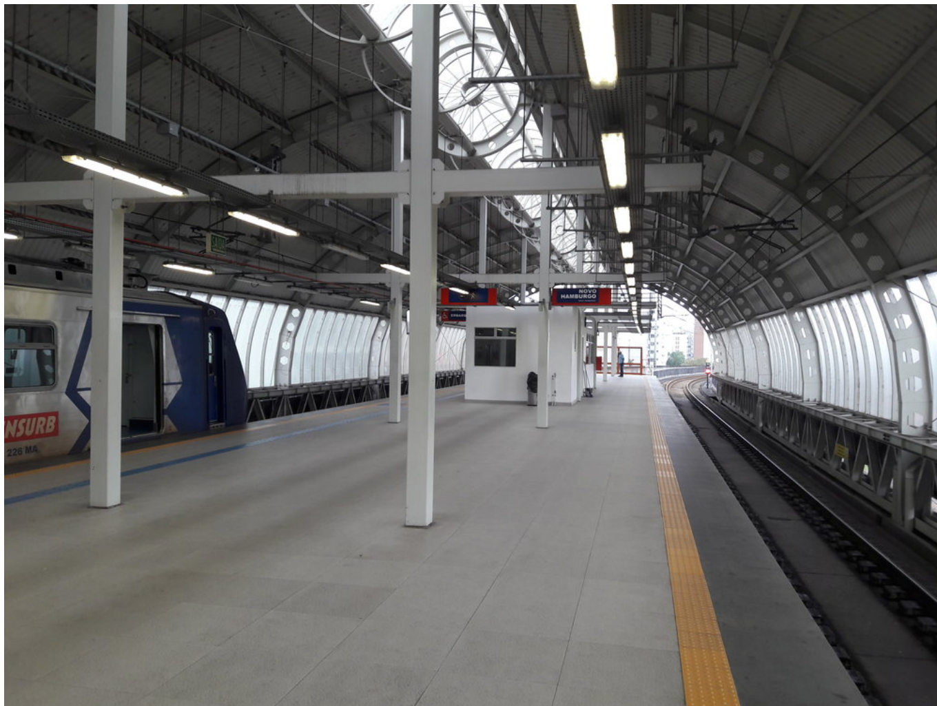
Konečná stanice Novo Hamburgo.
