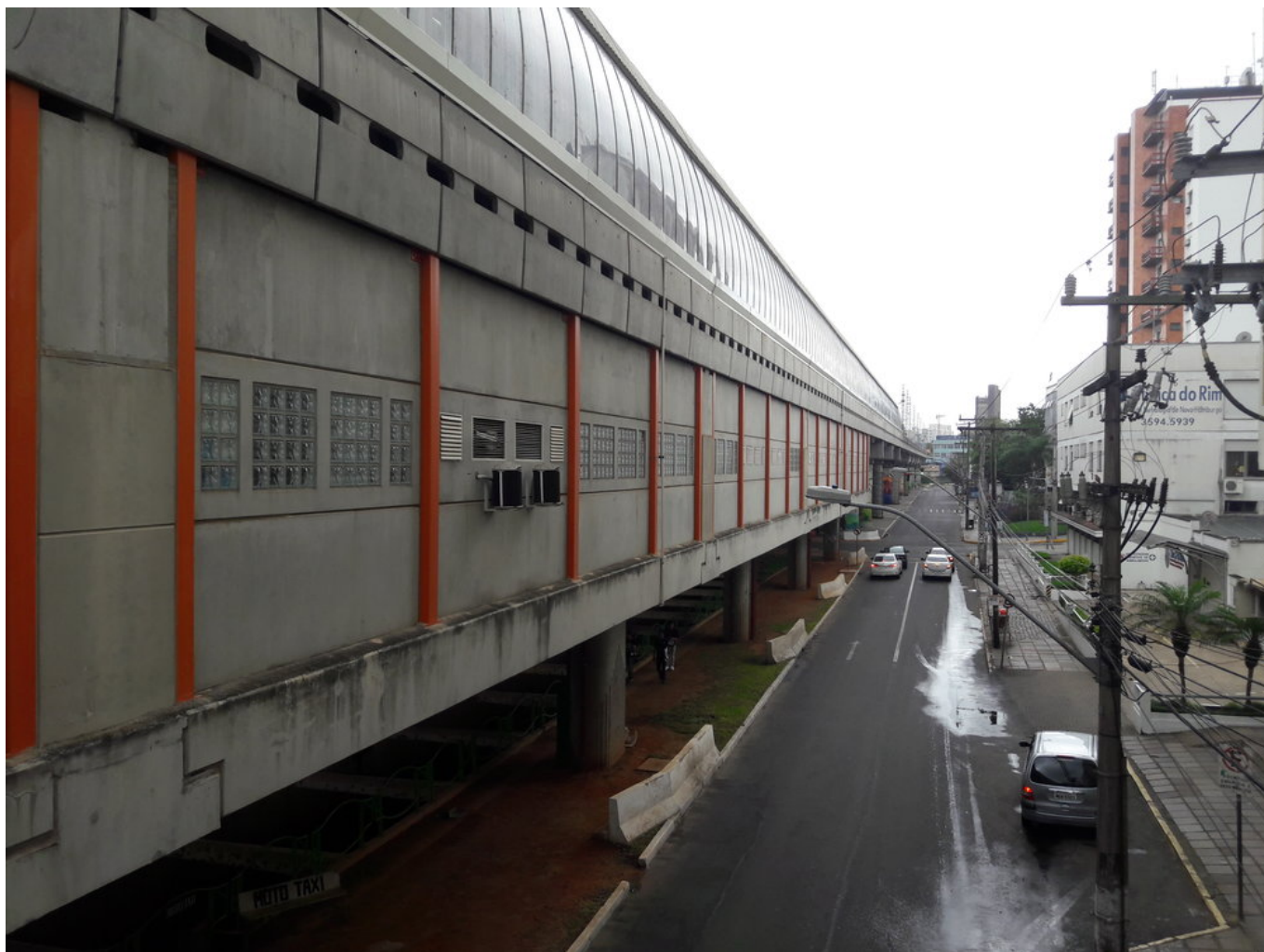
Novo Hamburgo. Východní strana stanice. Pohled na sever, kde estakáda končí.
