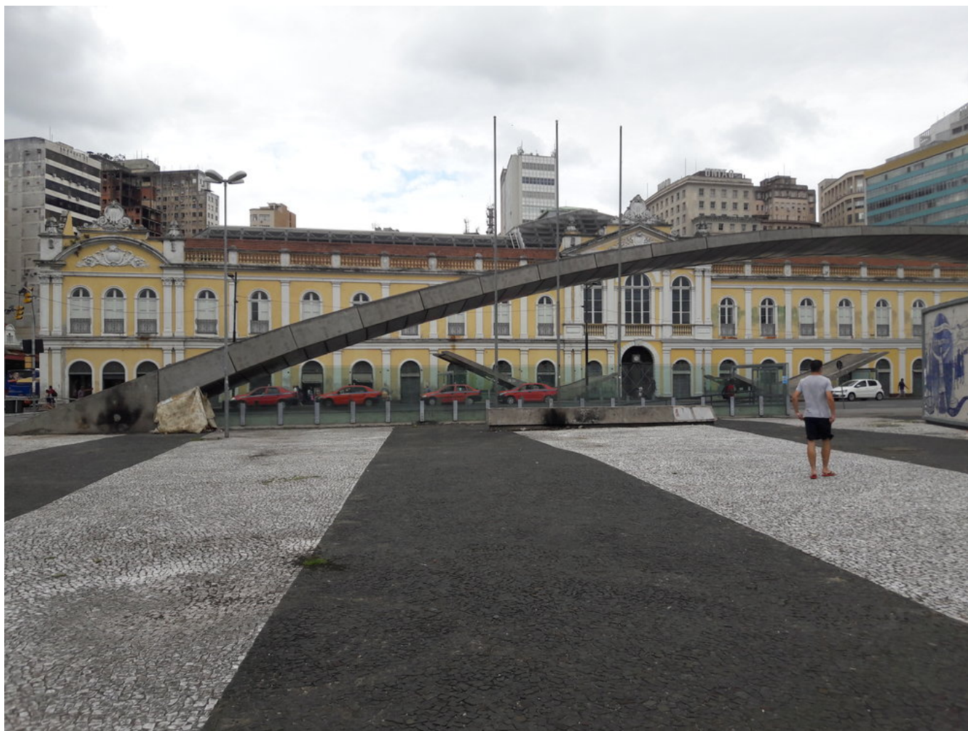
Vchod do výchozí stanice Mercado je kvůli silnici podzemní.
