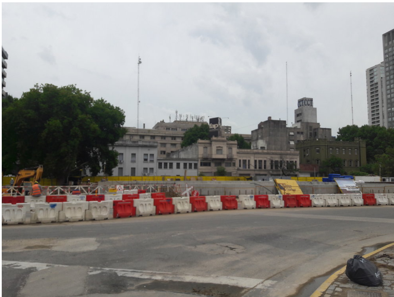
Těmito místy se proháněla tramvaj. Jižní úsek tehdy rovné cca 2 km dlouhé trati. (30. 1. 2019)
