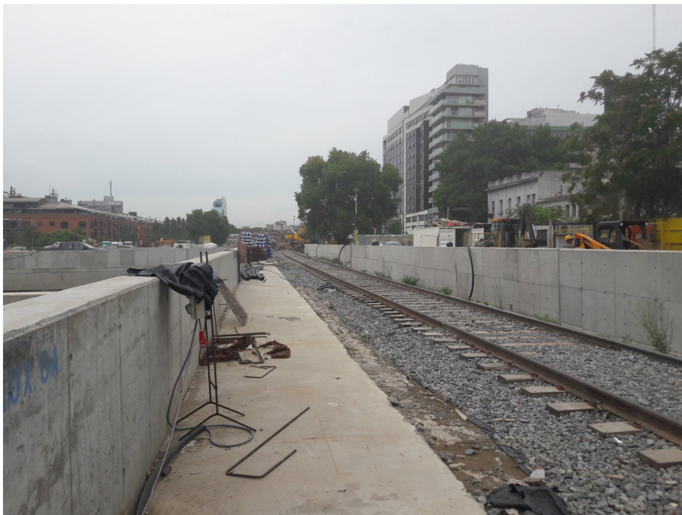
Jediné, co se podařilo zachovat, je železniční spojka (vlečka) z přístavu. Pohled na jih.
