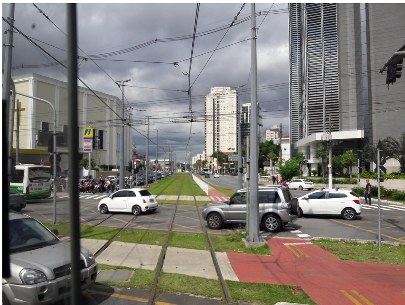
Křížení trolejí lehkého metra s těmi trolejbusovými.
