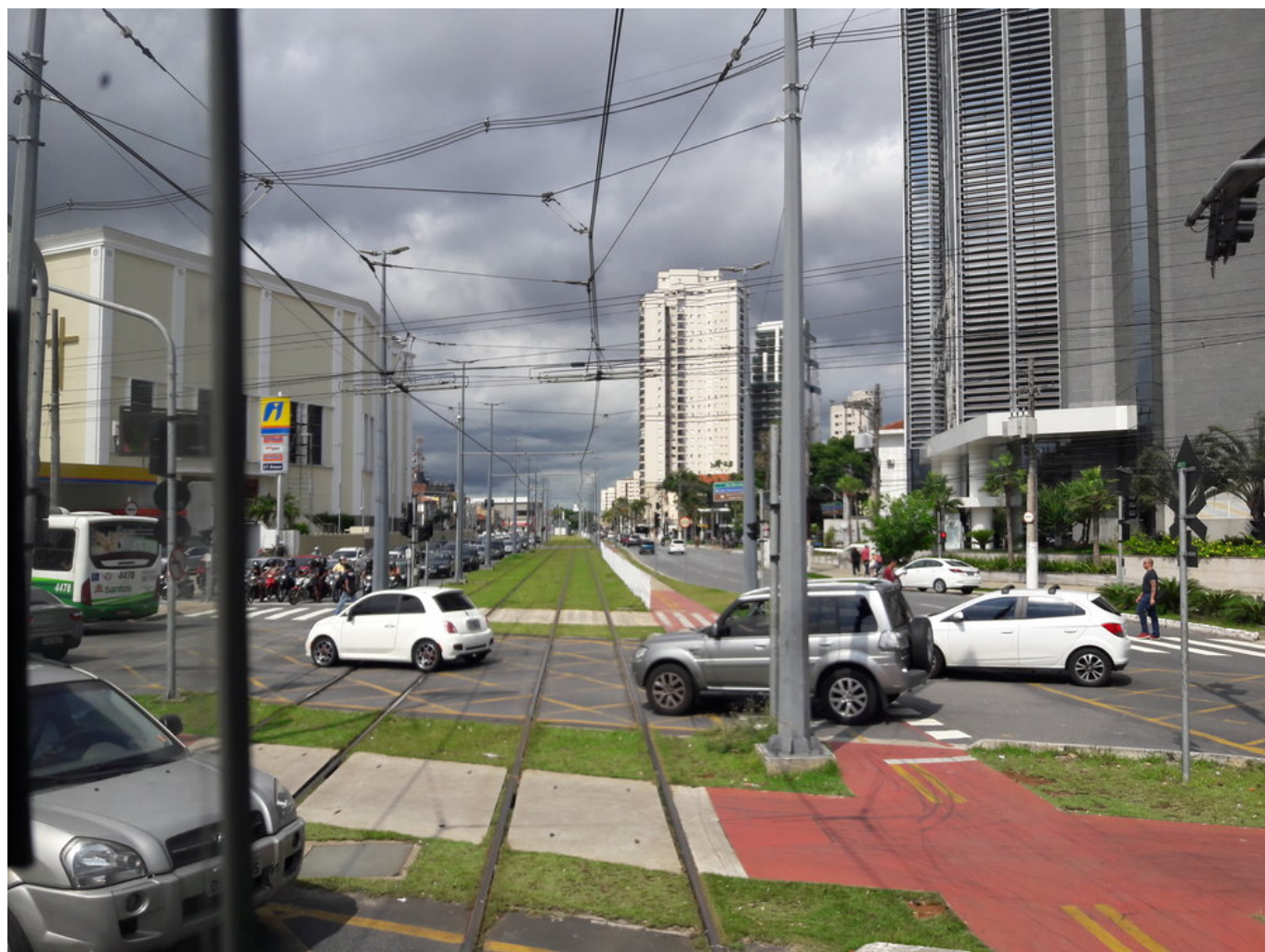
Křížení trolejí lehkého metra s těmi trolejbusovými.
