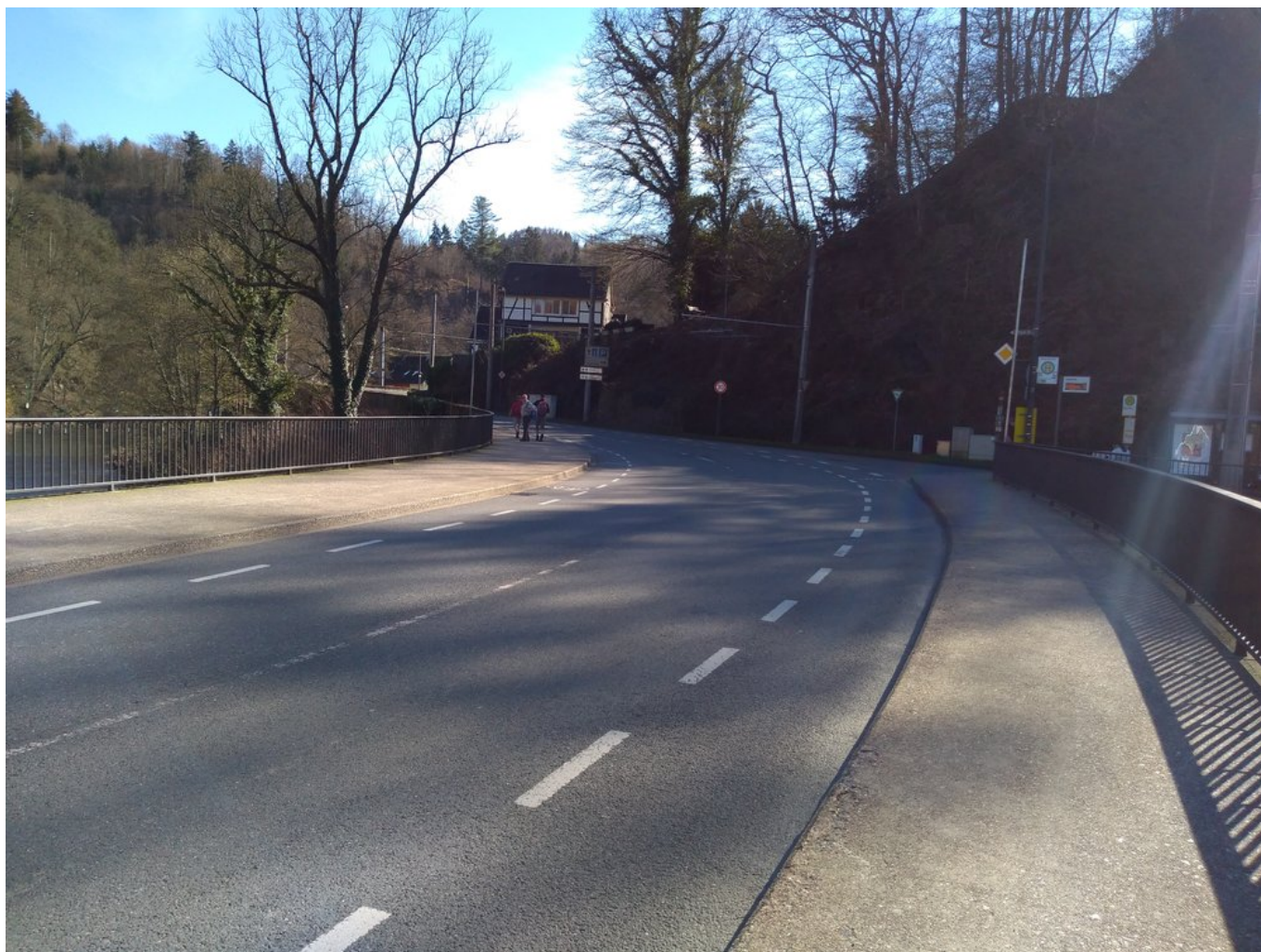
Na mostě přes řeku Wupper. Pohled ze solingenské městské části Burg an der Wupper na jinou solingenskou městskou část Unterburg.
