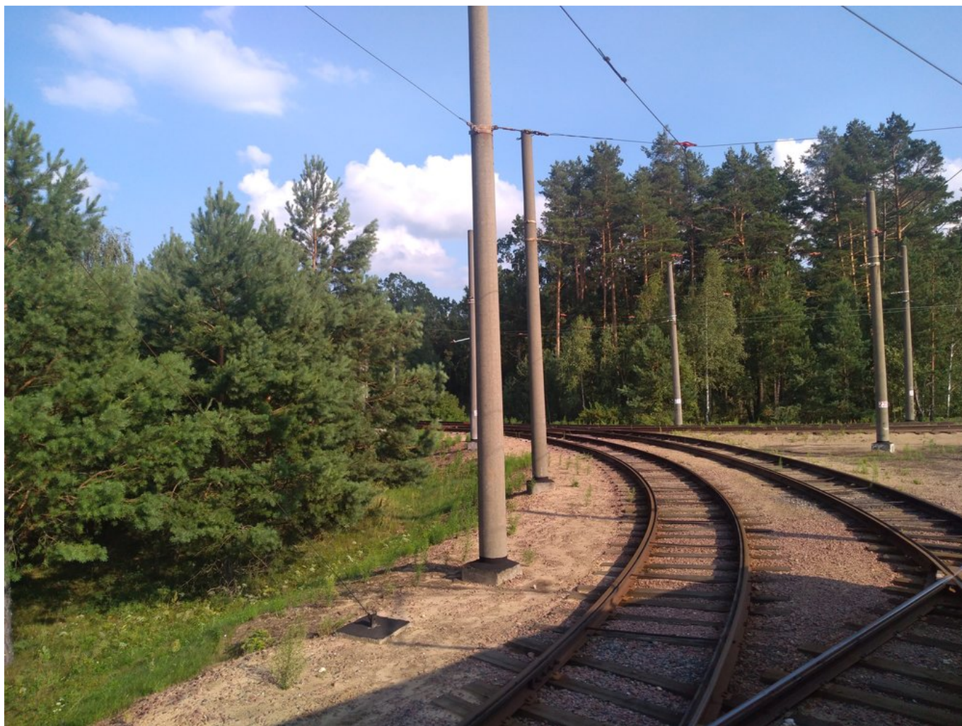
2. nácestná smyčka ve směru do závodu. Je posazena na vysokém náspu.
