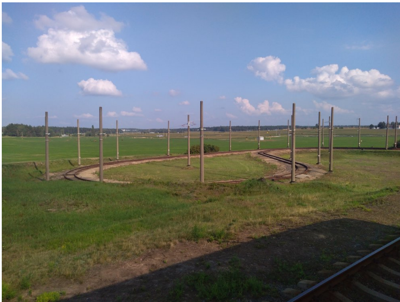
1. nácestná smyčka ve směru k závodu.
