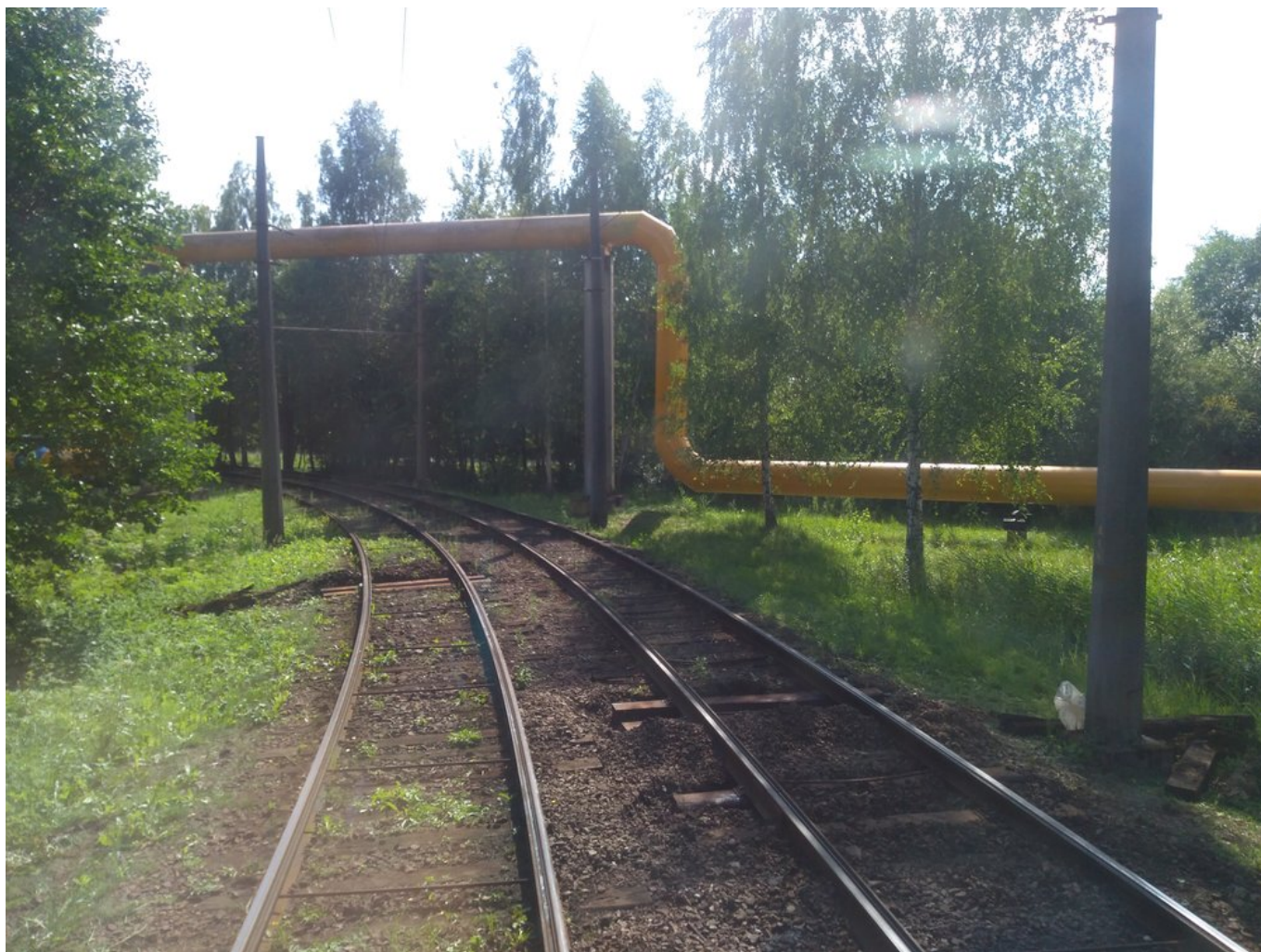
Kolem trati se krouťí různé roury a potrubí.
