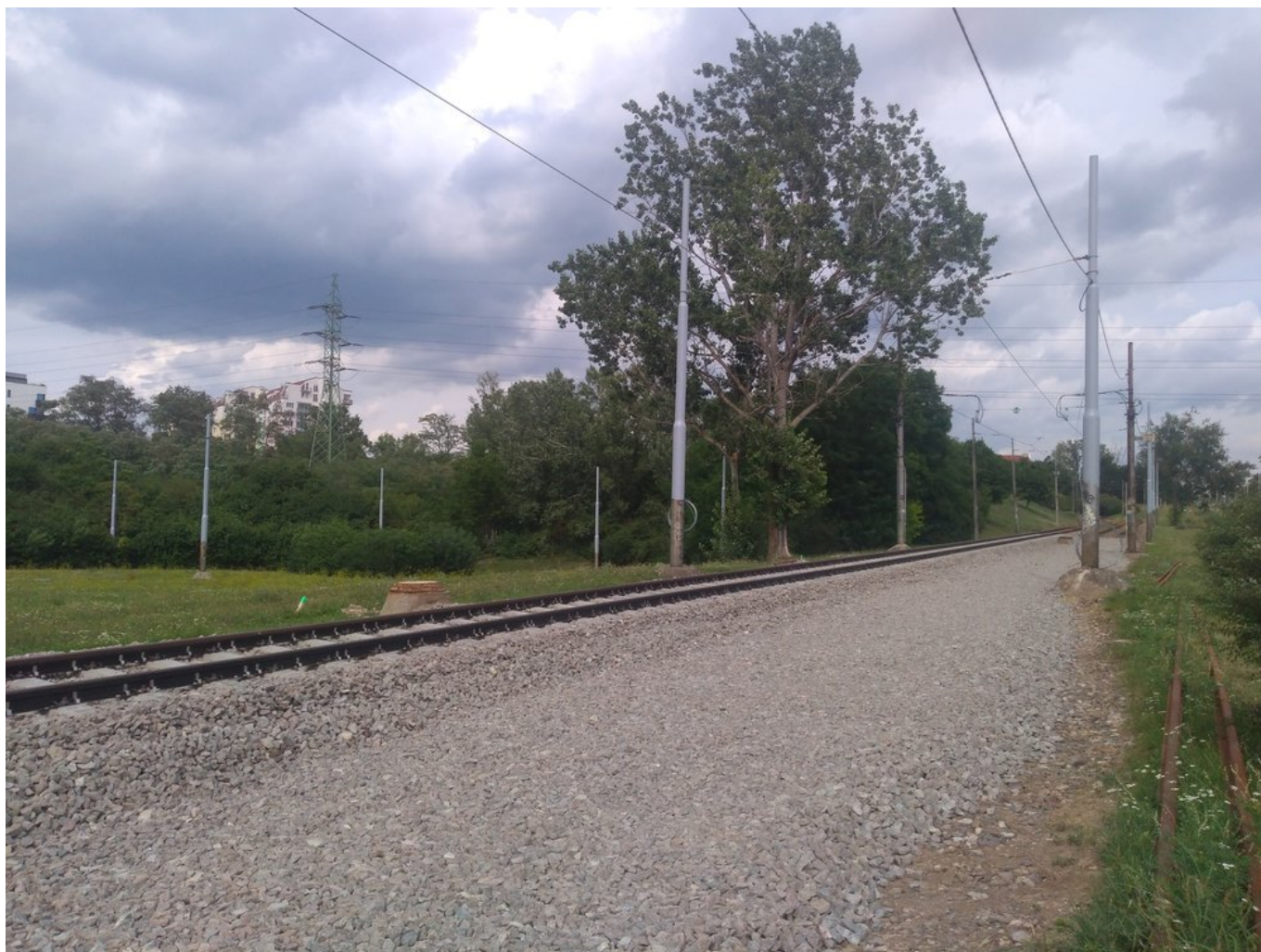
Pohled na rekonstrukci paralelní tramvajové trati.
