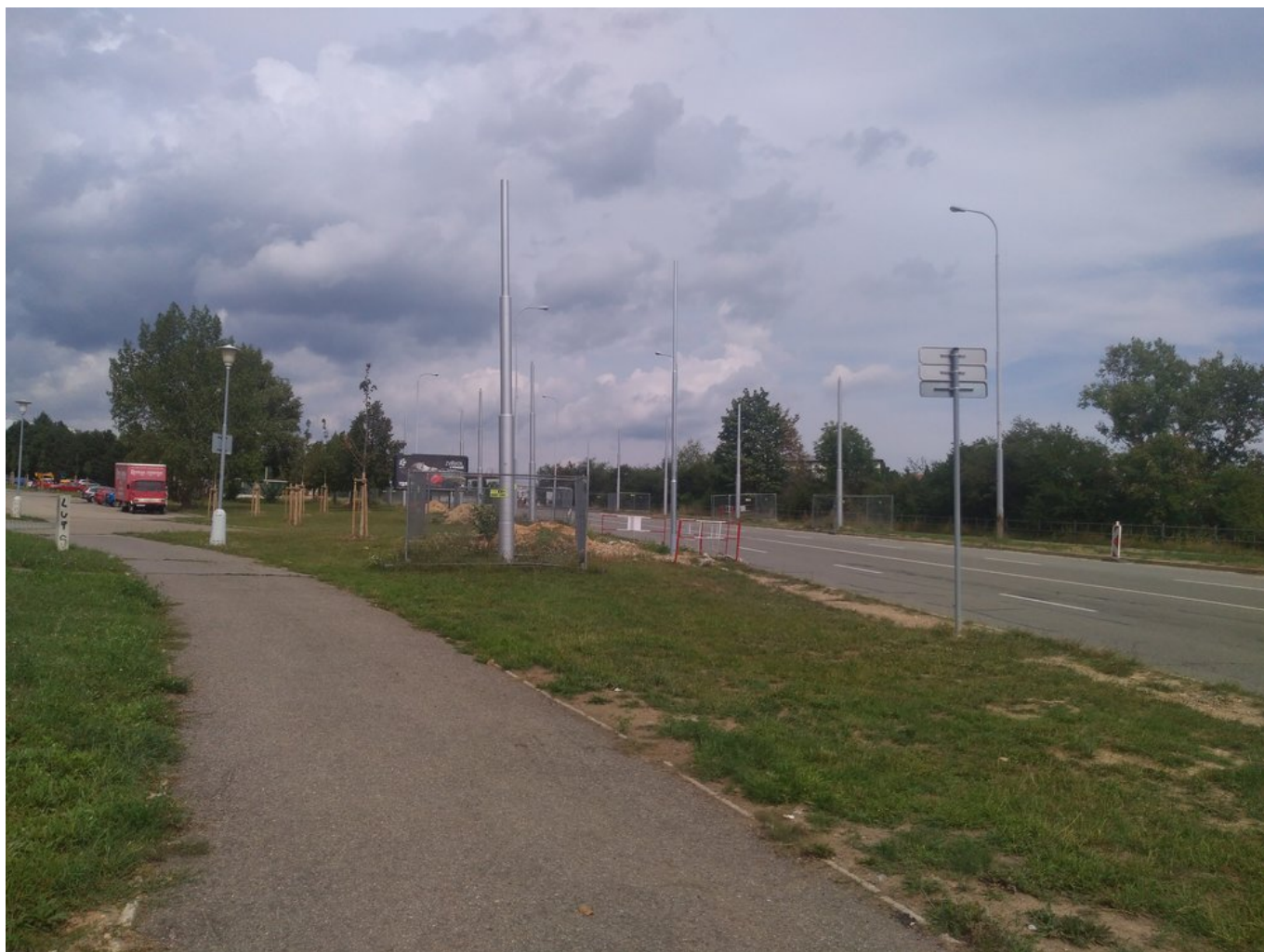
Tato galerie ukazuje horní část nového úseku.
