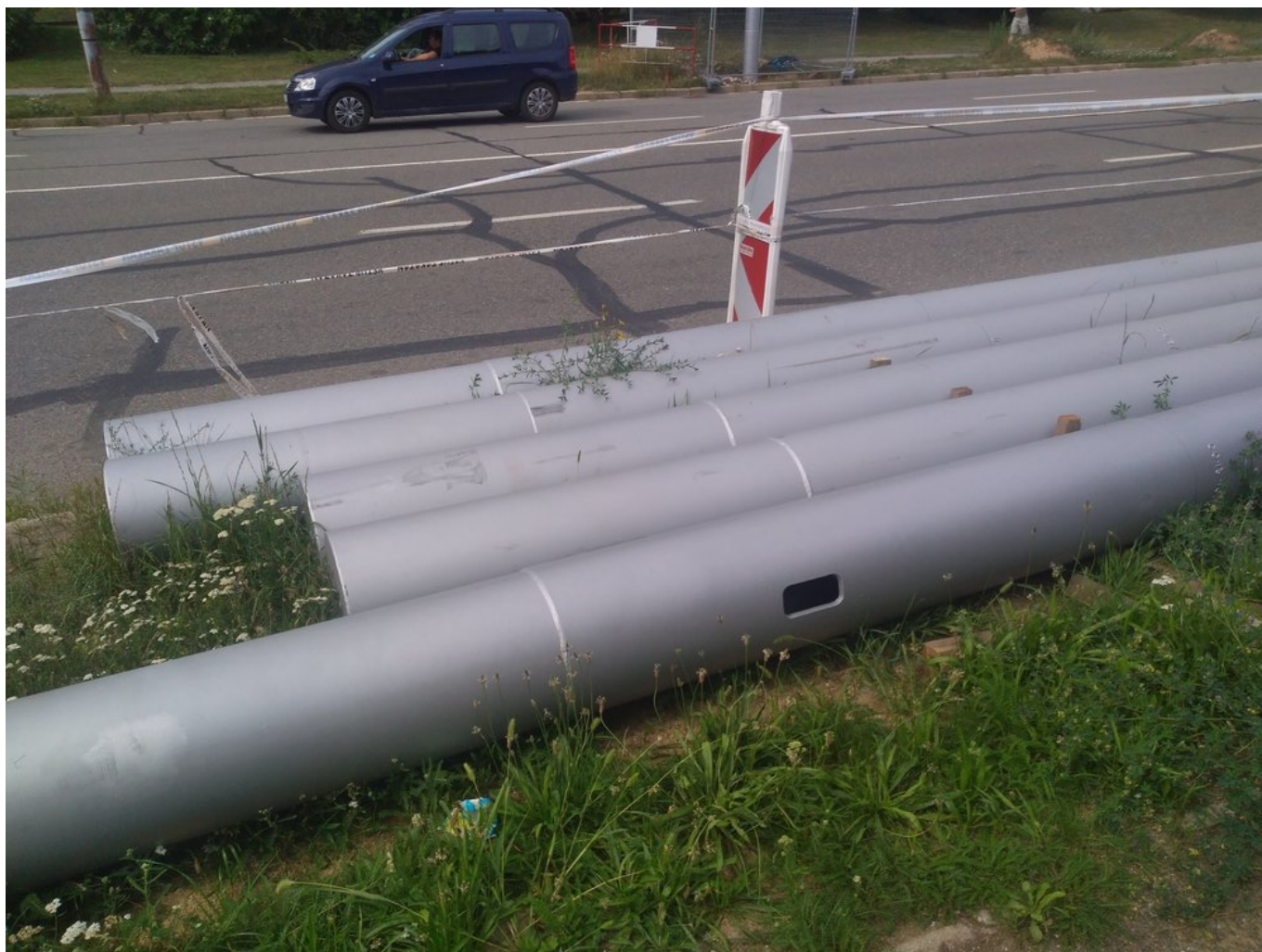
Pohled na sloupy s detailem na dutinu v jednom z nich.
