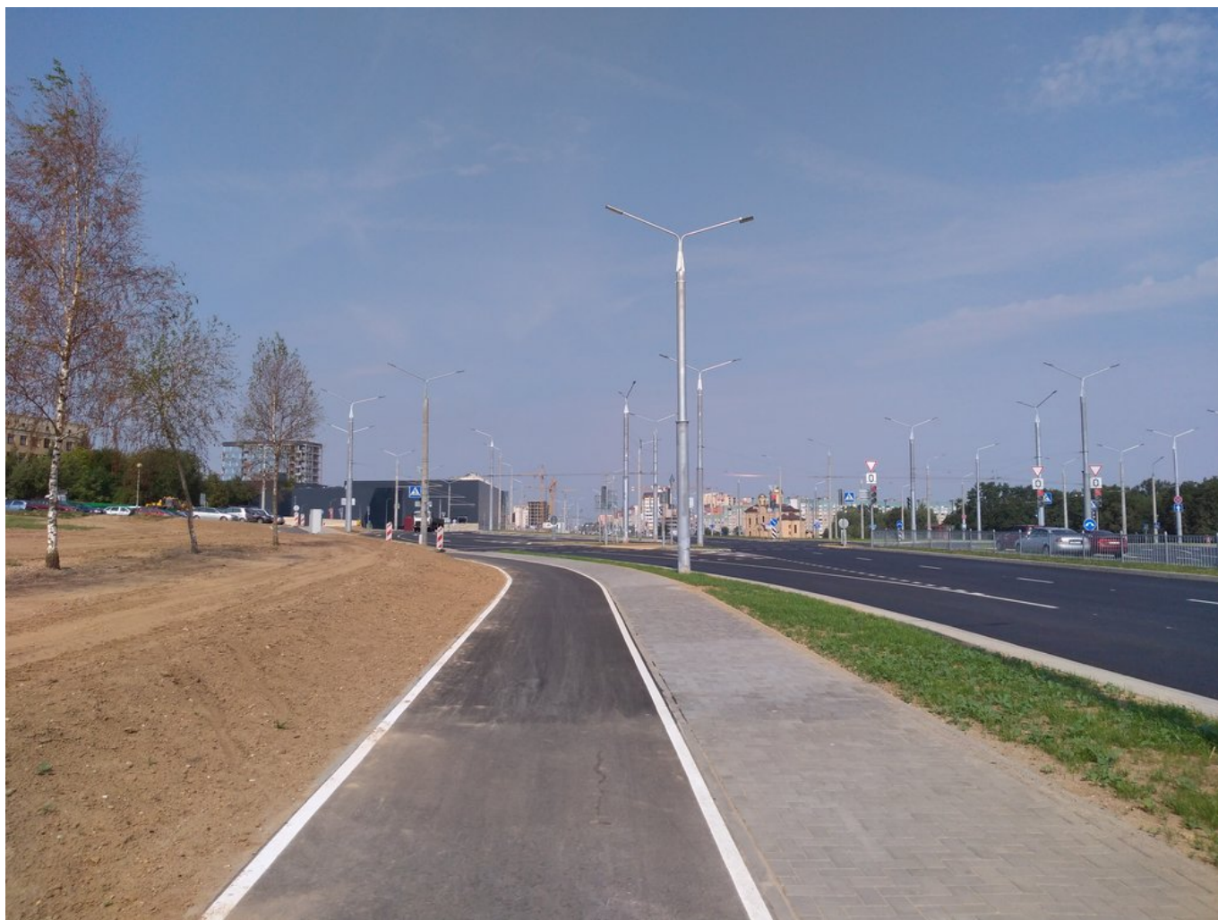
Pohled na nové obratiště u budovaného obchodního centra Triniti.
