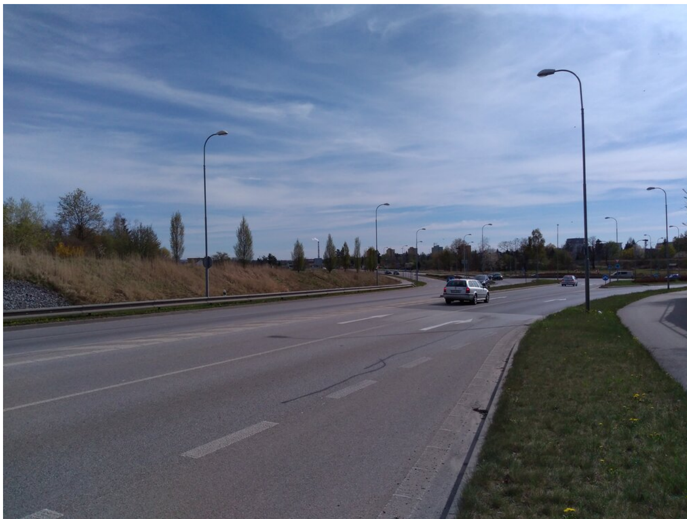
Pohled směrem do centra (kruhový objezd s ulicí Vodní).
