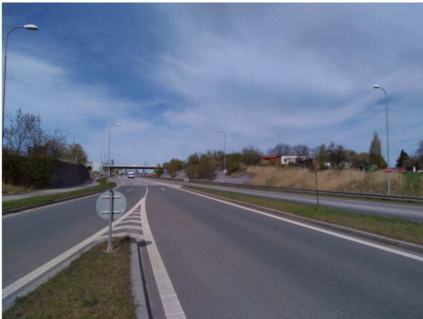
Pohled zpět směrem k vozovně.
