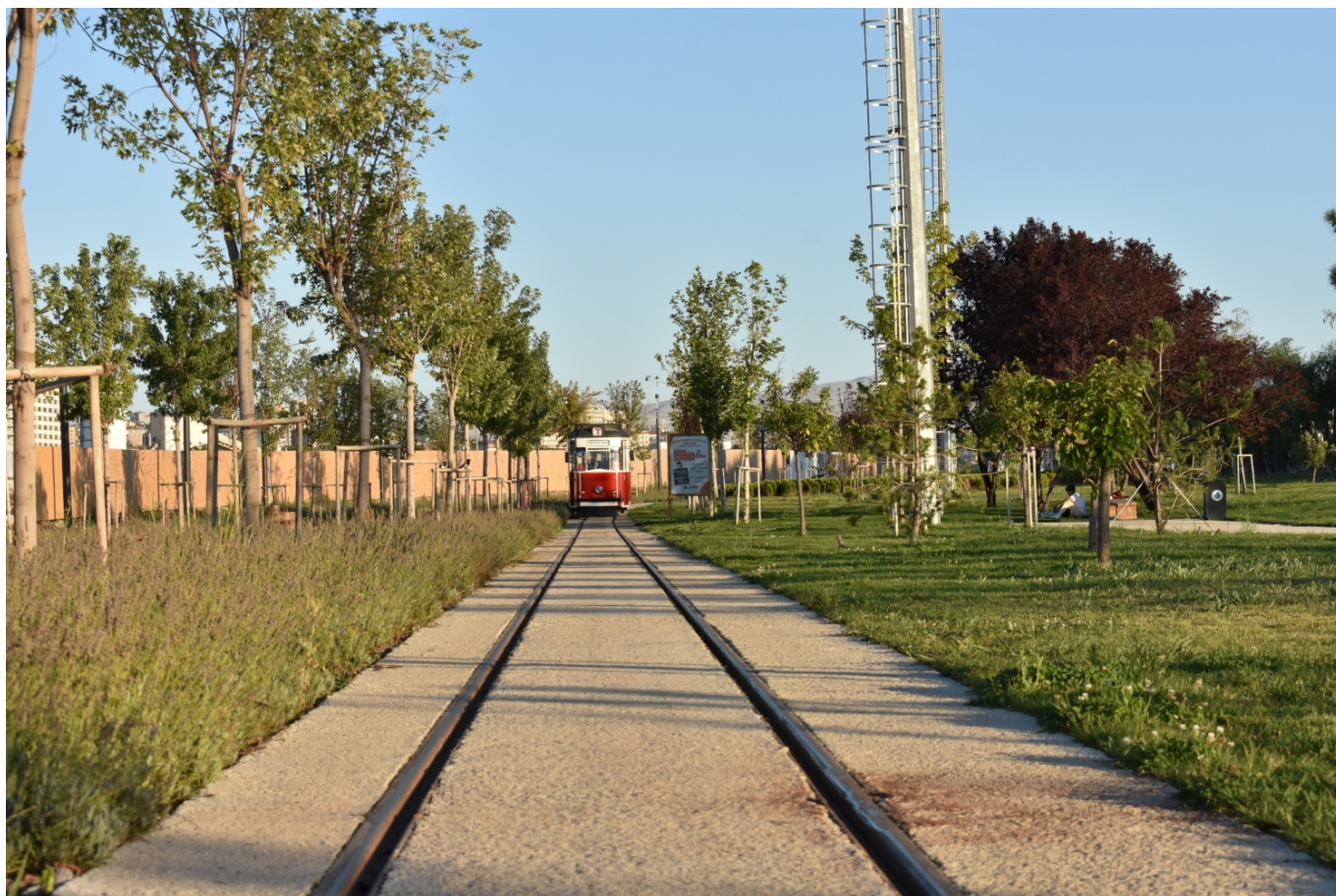
Detail provedení tramvajové trati. (foto: Libor Hinčica)
