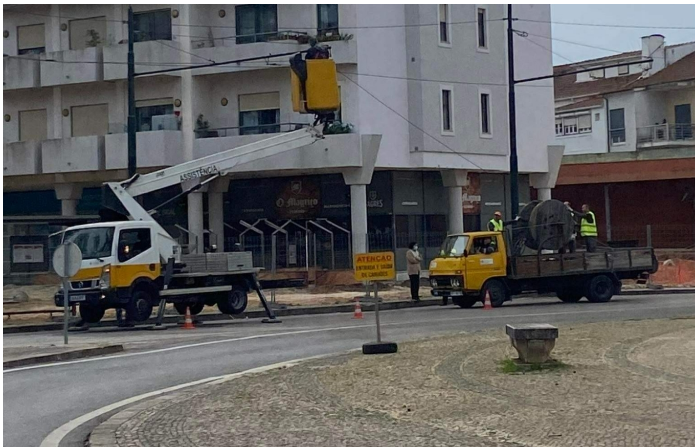
Likvidace trolejí na náměstí 25 de Abril na snímku z března 2022. (foto: Noticias de Coimbra)
