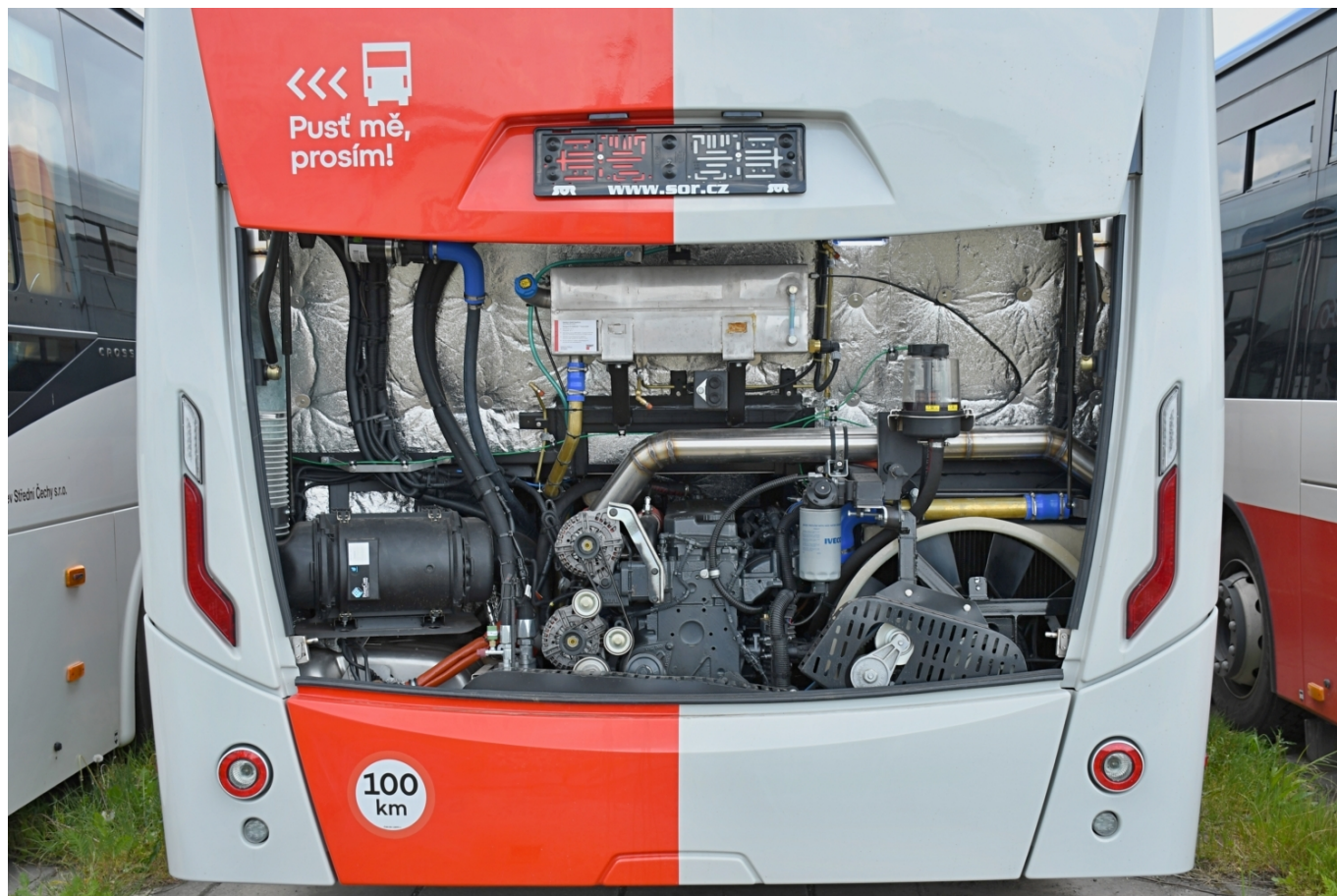
Pohled do útrob motorového prostoru. (foto: Vojtěch Mařík)
