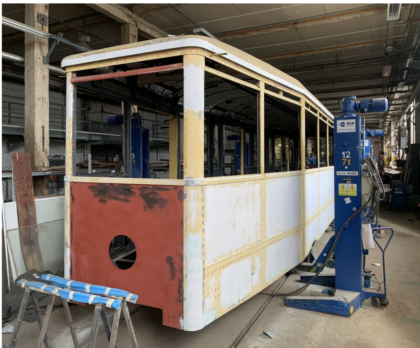
Vůz ev. č. 3098 během opravy v Krnovských opravách a strojárnách. (foto: Libor Hinčica)
