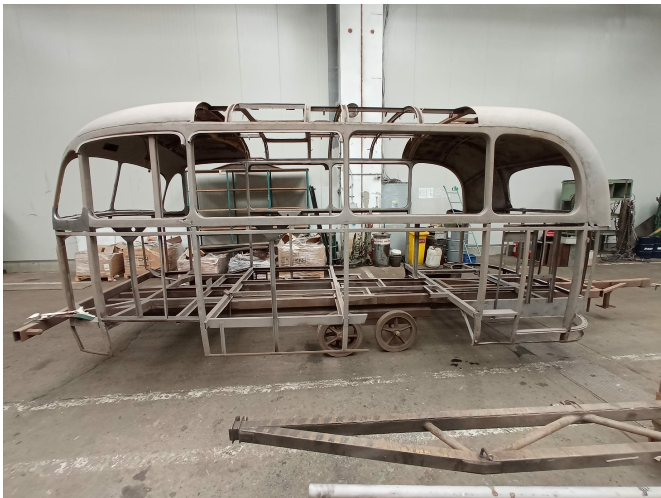
Sejmutá a odstrojená skříň autobusu ve Zlineru v březnu 2022. (foto: archiv Boveraclub)
