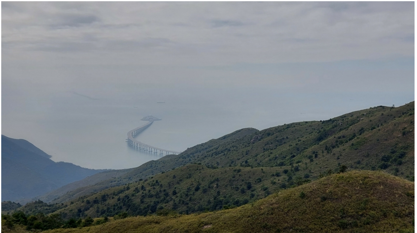
Pohled z Lantau Island na část mostu, resp. systému tvořeného třemi mosty a tunelem, spojujícího Hongkong s Macaem. (foto: Lukáš Vrána)
