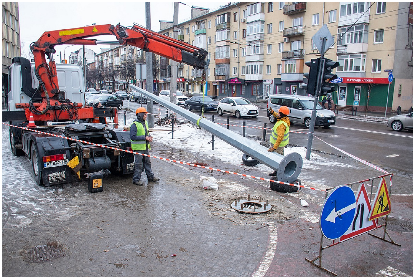
Stavba trolejbusové trati na snímku z ledna 2022. (foto: ElektroAvtoTrans)
