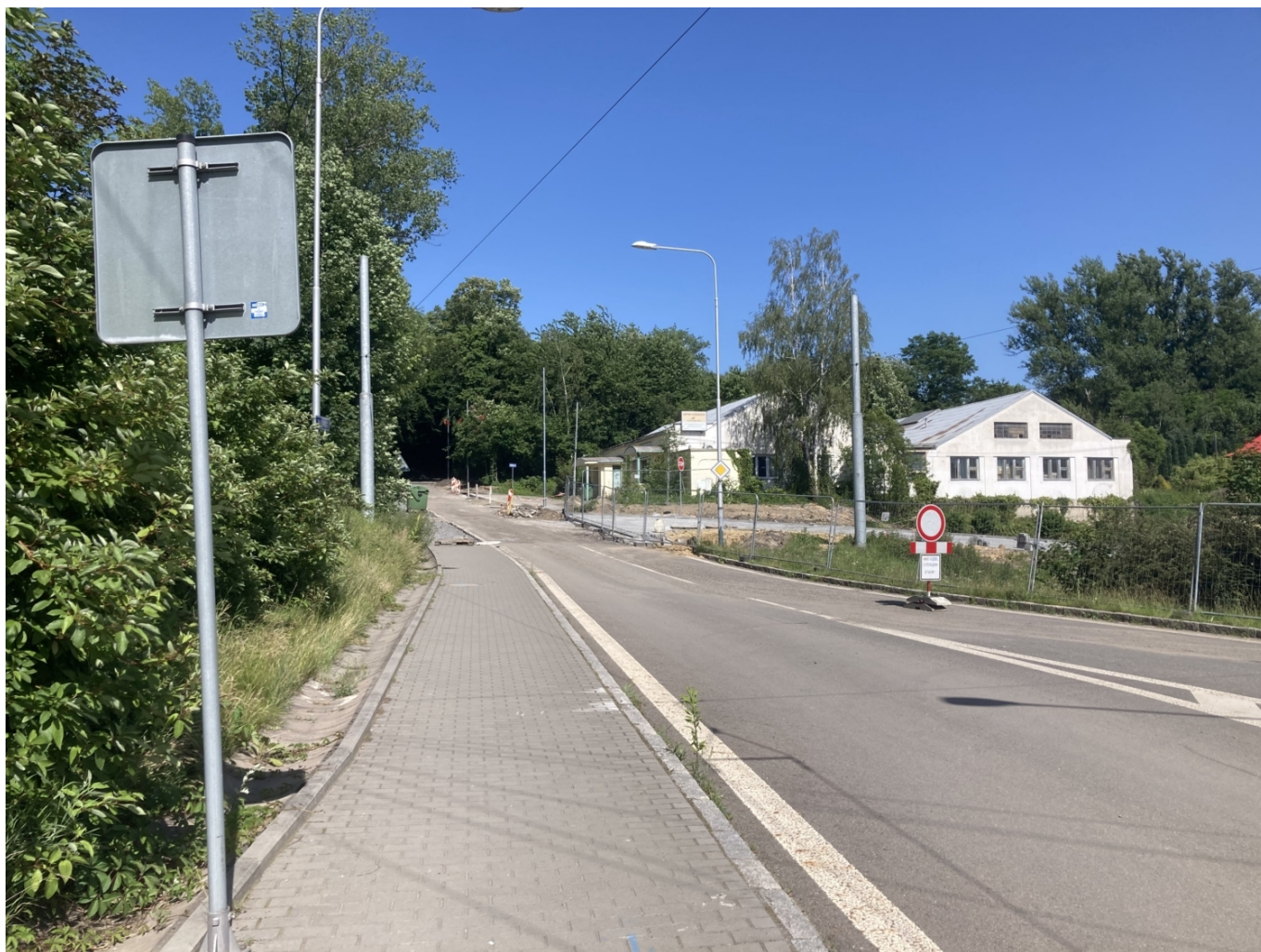
Spodní část ulice Na Baranovci.
