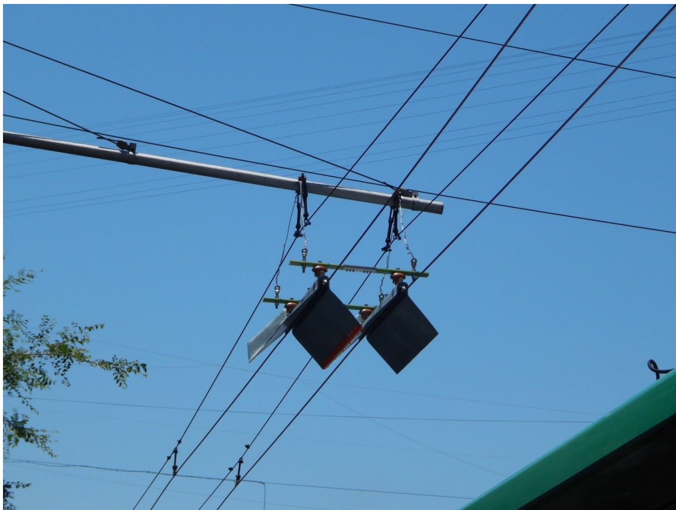
Detail provedení natrolejovací stříšky v Jerevanu. (foto: Artavazd Khachatryan)
