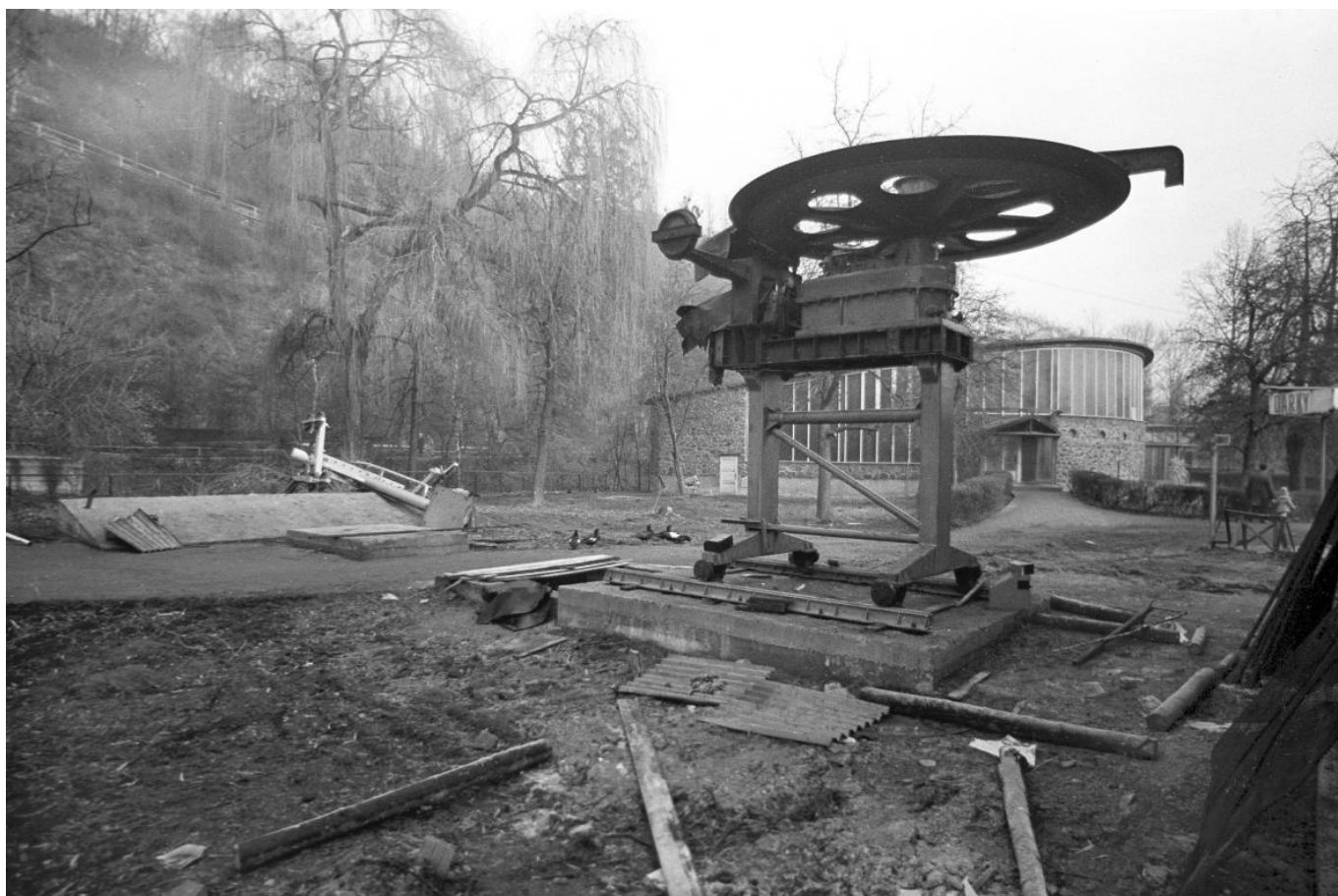
Výstavba spodní stanice sedačkové lanové dráhy v areálu ZOO Praha na snímku z roku 1974. (zdroj: ZOO Praha, foto: Vladimír Motyčka)
