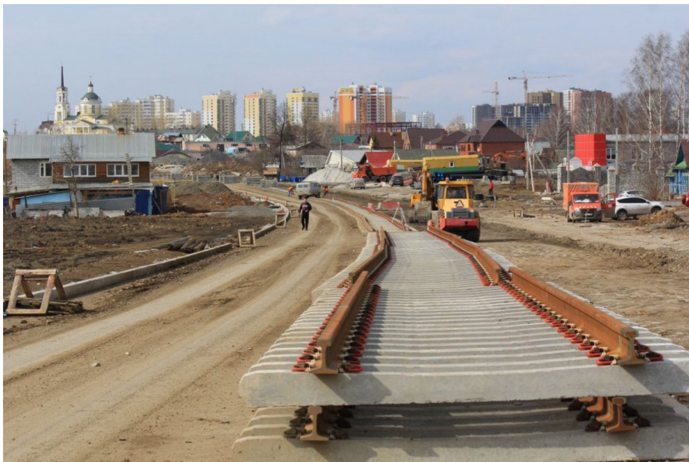
Ze stavby trati. Většina pražců je betonová. (foto: Администрация города Екатеринбурга)
