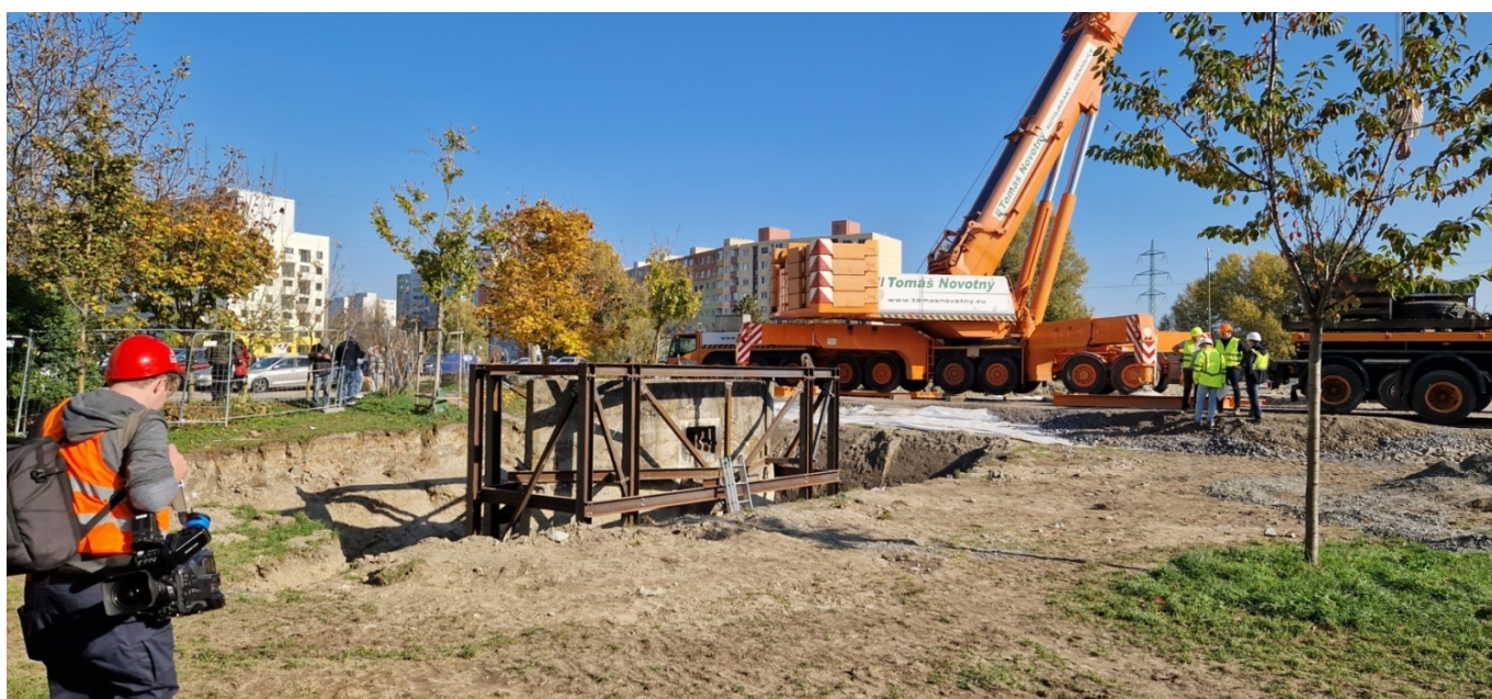
Palebné postavení v nové pozici ještě s převozní „klecí“. Rameno jeřábu přesunulo betonovou stěnu
