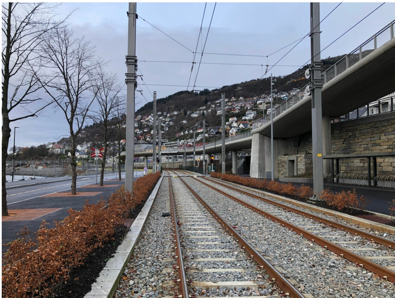
Provedení nové tramvajové tratě linky č. 2 v Bergenu. (foto: Rikard Ågren)
