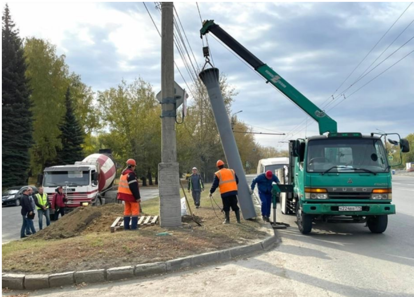
Výměna trakčních stožárů na snímku z podzimu 2022.
