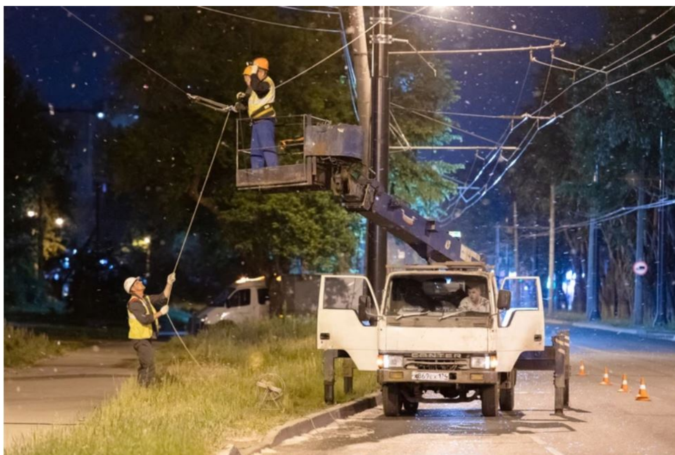
Výměna trakčních stožárů na snímku z podzimu 2022.
