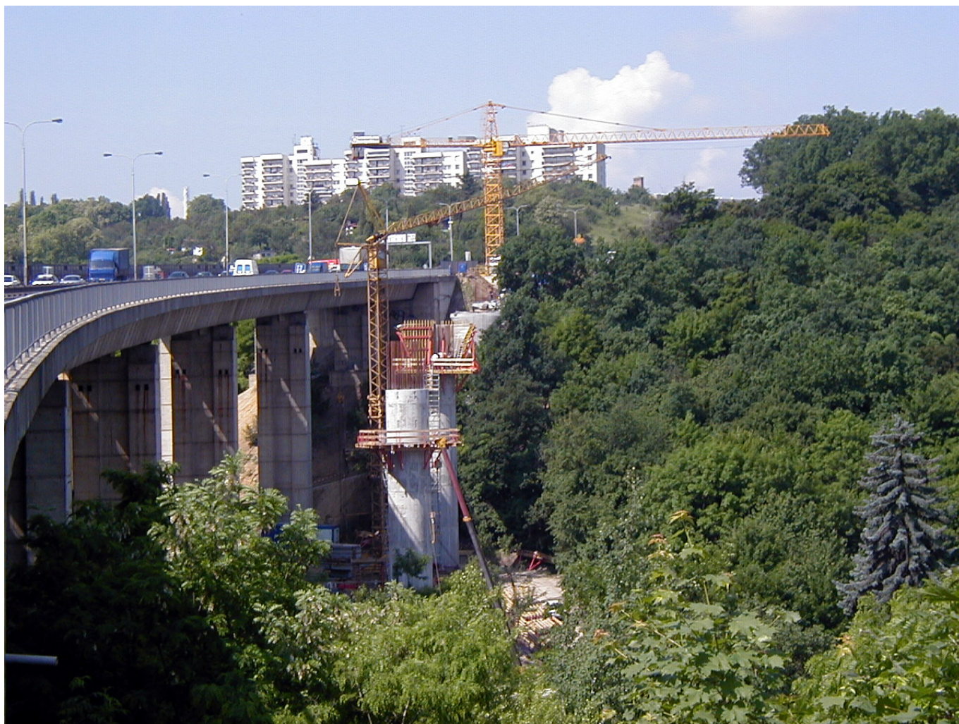
Stavba pilířů tramvajové estakády na Barrandov. (foto: Jiří Kejdana)
