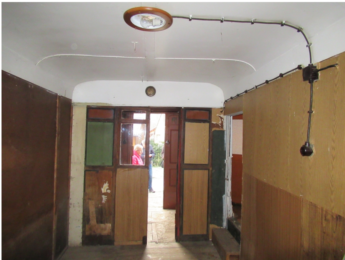
Přepážka do kuchyně byla tvořena ze zadních dveří autobusů Praga NO. (foto: Luděk Vidím)
