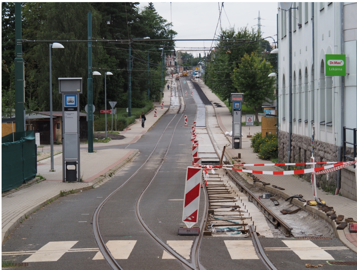
Úpravy změny rozchodu kolejí v ulici U Sila mezi zastávkami Lékárna a Pivovarská (19. srpna 2021; foto: Zdeněk Mazánek)
