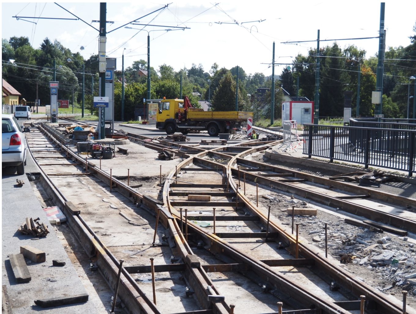
Přerozchodované kolejiště v prostoru smyčky ve Vratislavicích nad Nisou na snímku z 24. září 2021. (foto: Zdeněk Mazánek)
