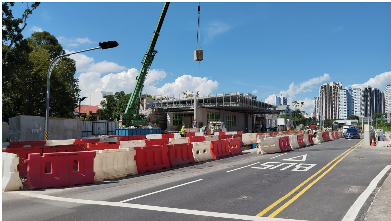
Výstavba stanice Siglap na Thomson-East Coast Line v červenci 2023. (foto: Lukáš Vrána)
