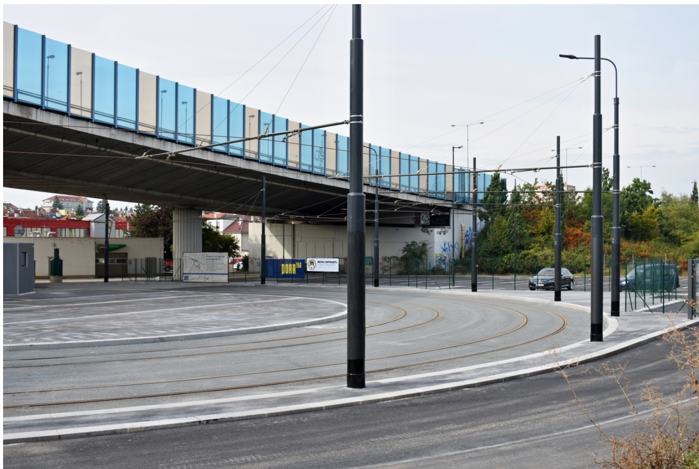
Pohled na nové obratiště od železniční tratě. V pozadí je patrné částečně zachované záchytné parkoviště P+R. (foto: Matěj Stach)
