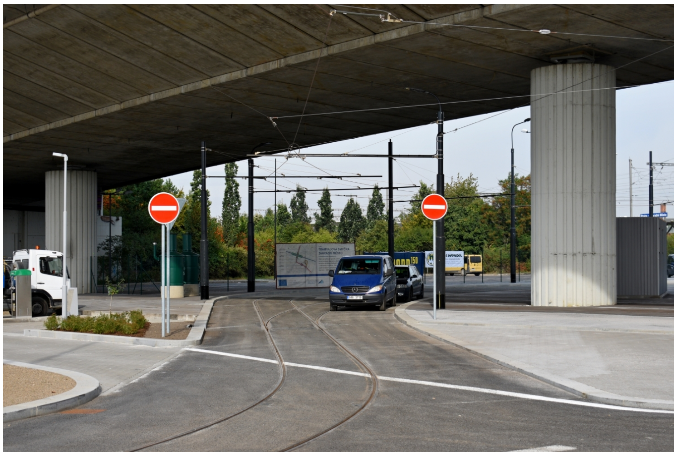
Výjezd z nové smyčky. (foto: Matěj Stach)
