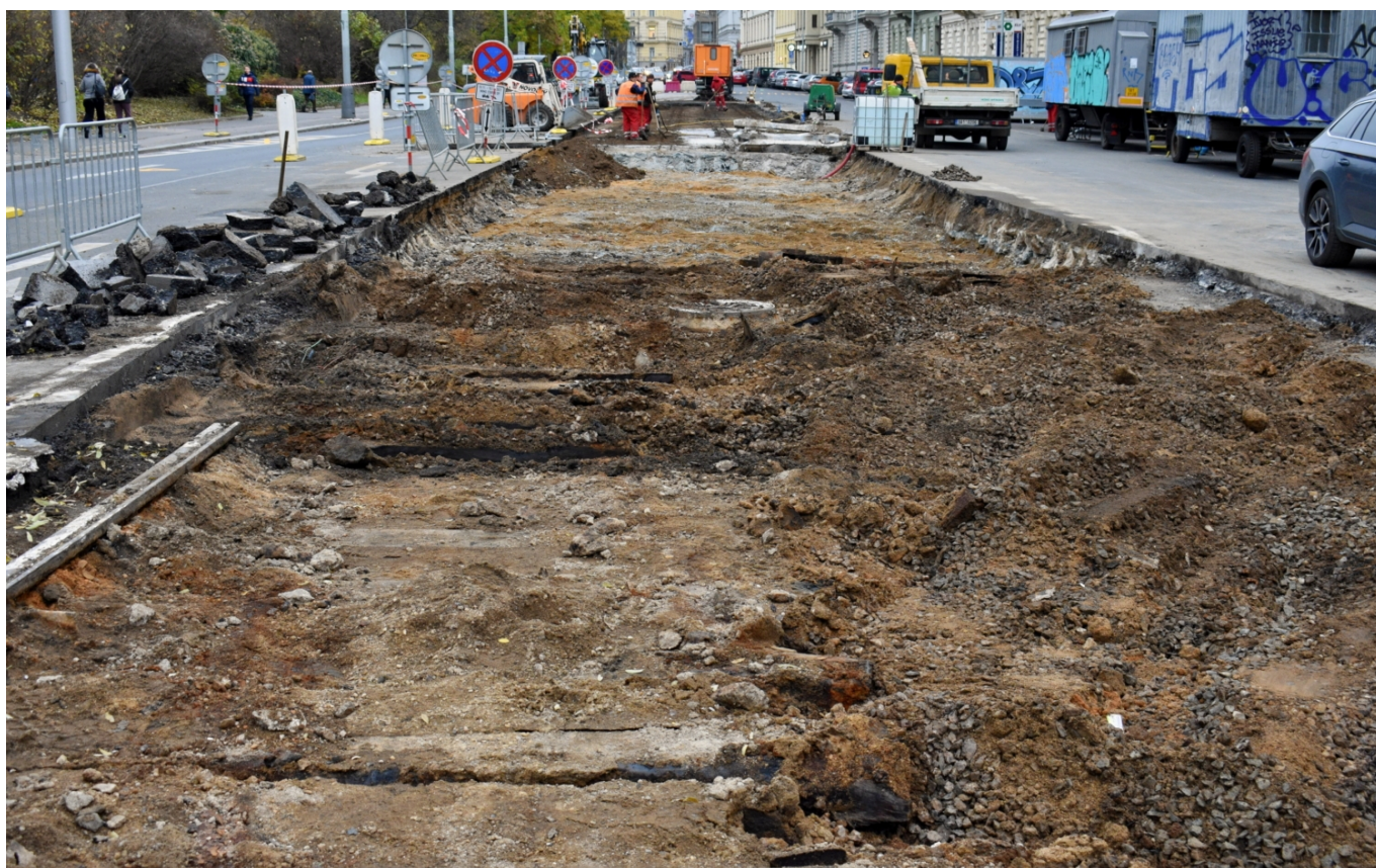
Odkryté podloží pod tratí v Opletalově ulici spolu se zbytky nevyjmutých prachů. (foto: Matěj Stach)
