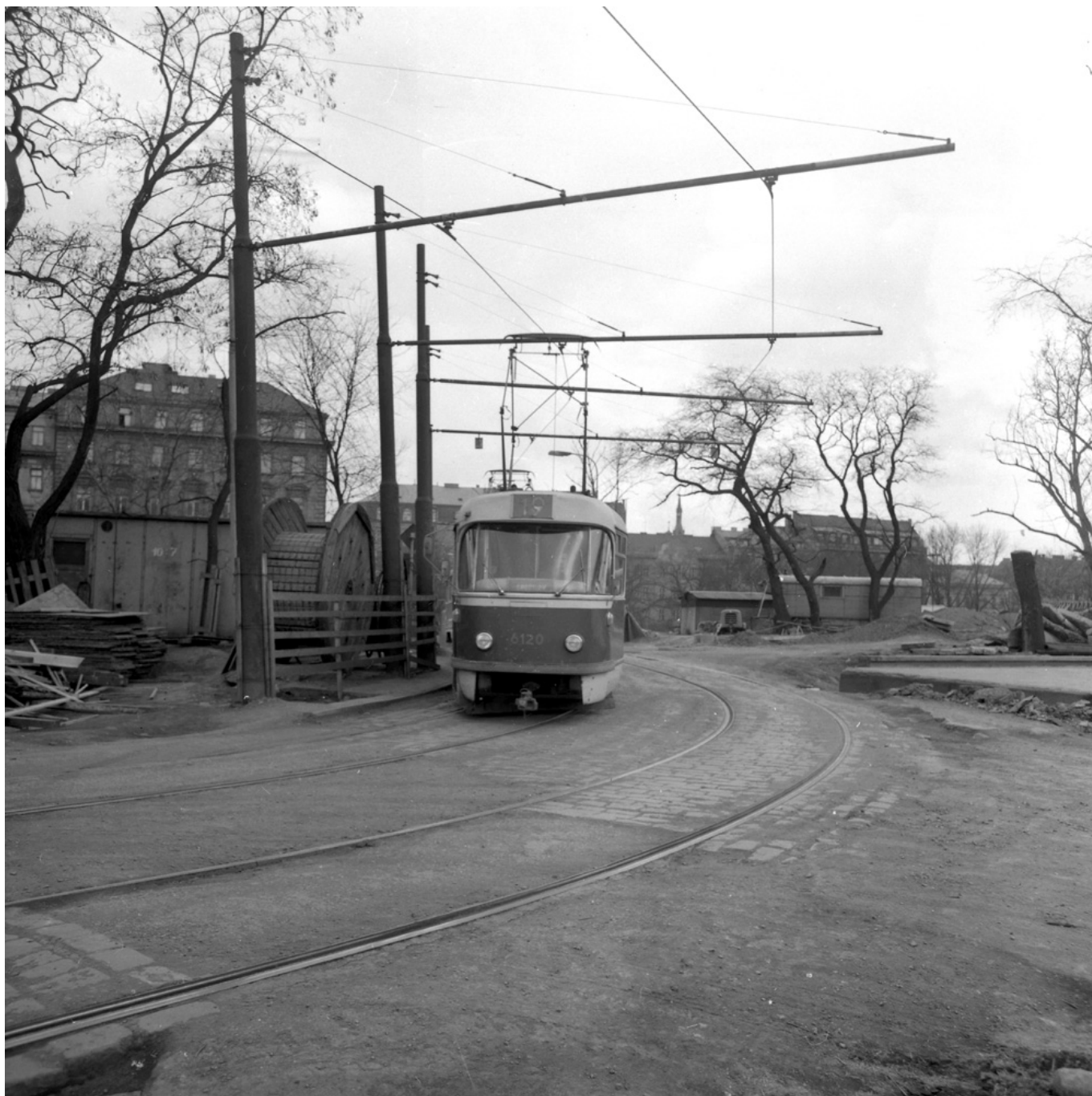
Tramvajový vlak vedený vozem T3 ev. č. 6120 vjíždí do odbočení z Opletalovy ulice směrem na dnešní Wilsonovu. (zdroj: archiv DPP)
