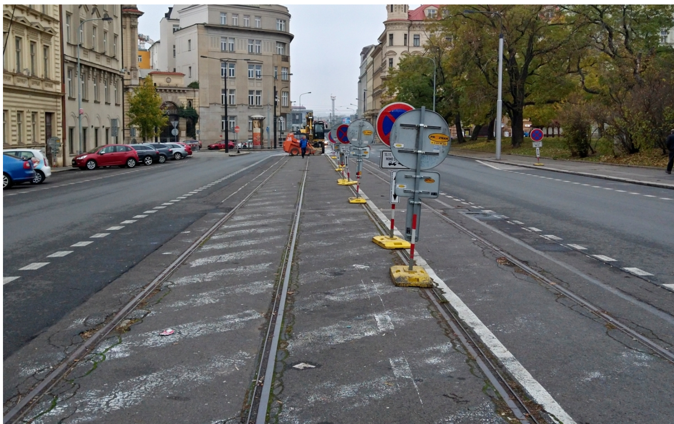
Torzo trati v Opletalově ulici bylo stejně jako těleso původní dráhy na Pankrác rychle adaptováno
