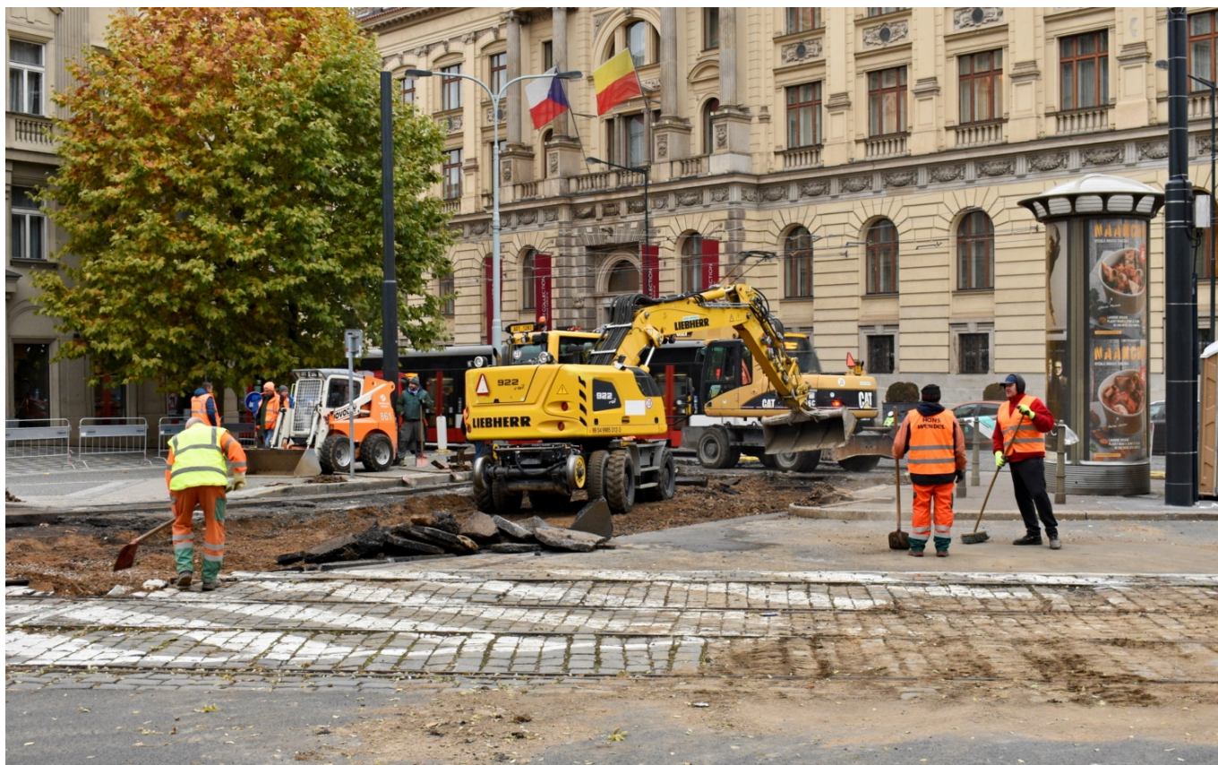
Budování propojení kolejového appendixu se stávající tratí na Senovážné náměstí. Nejbližší k fotografovi se nacházejí odpojené koleje dříve vedoucí do „malé Opletalovy“, které ve stávající etapě zůstanou netknuty. (foto: Matěj Stach)
