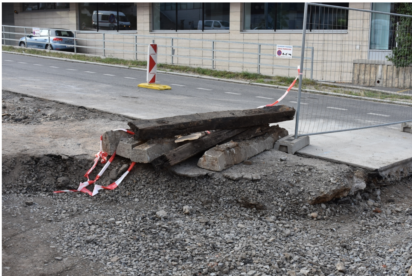
Vytěžené pražce z původní tramvajové trati používané v letech 1970-74. (foto: Libor Hinčica)
