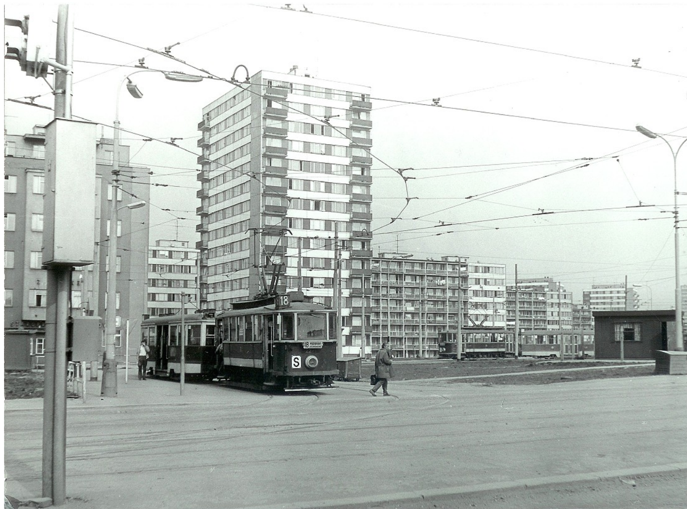
Tramvajovou smyčku na Budějovickém náměstí právě opouští souprava dvounápravových vozů v čele s vozem ev. č. 2276. (foto: Tomáš Dvořák)
