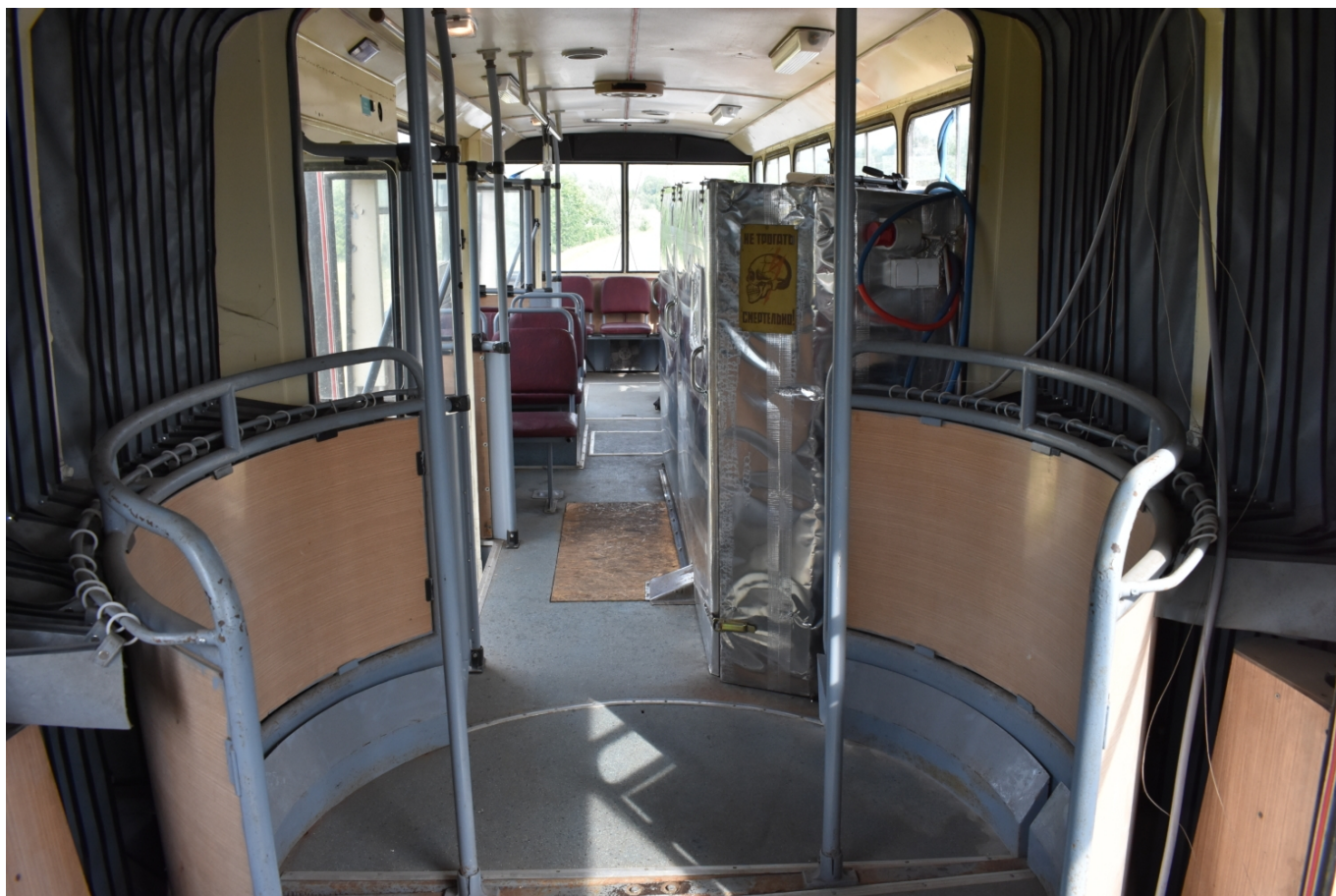
Pohled do interiéru na zastavěný dieselaagregát. (foto: Libor Hinčica)
