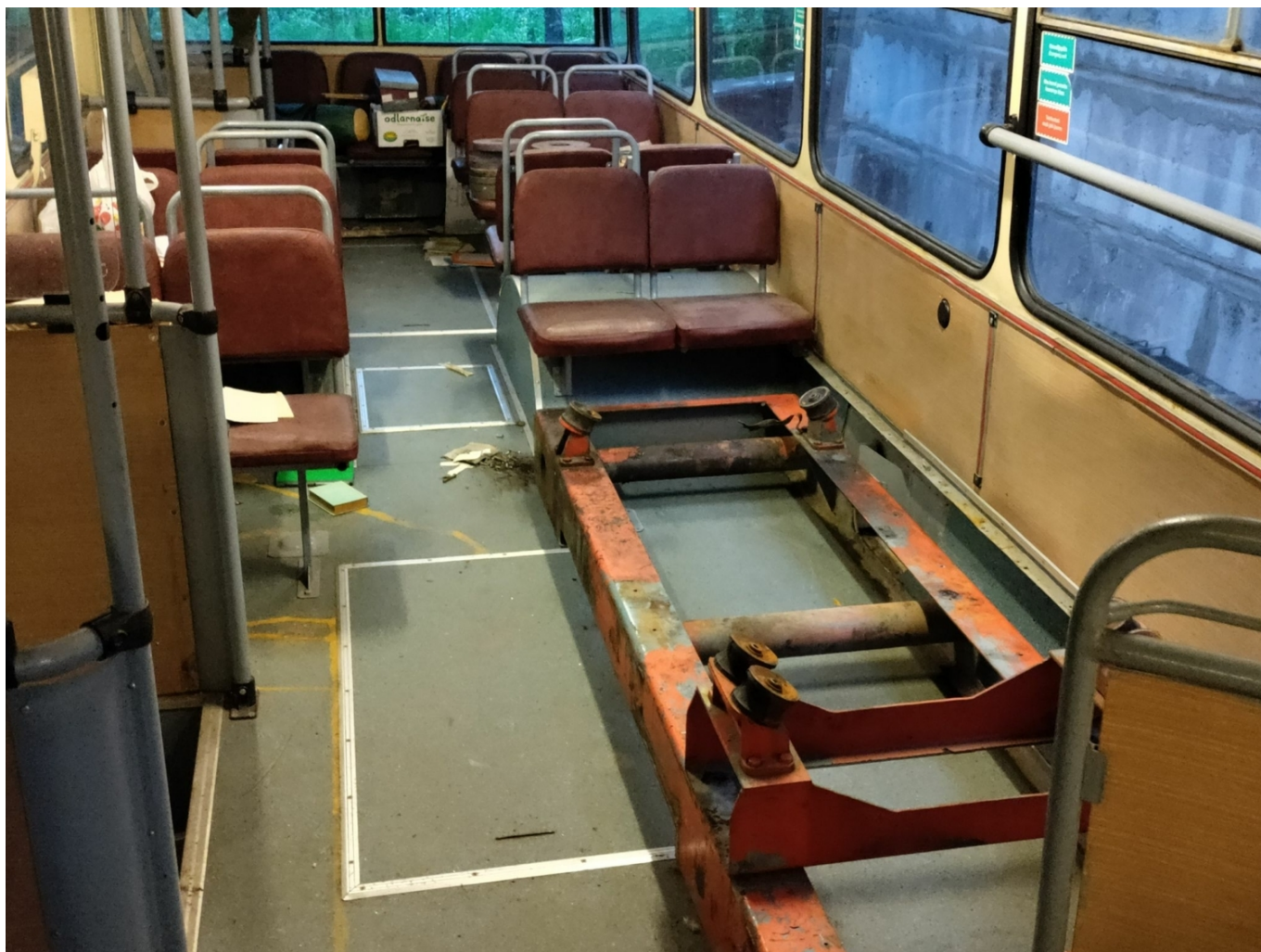
Příprava na umístění agregátu v interiéru vozu. (foto: Nigol Sobolev)
