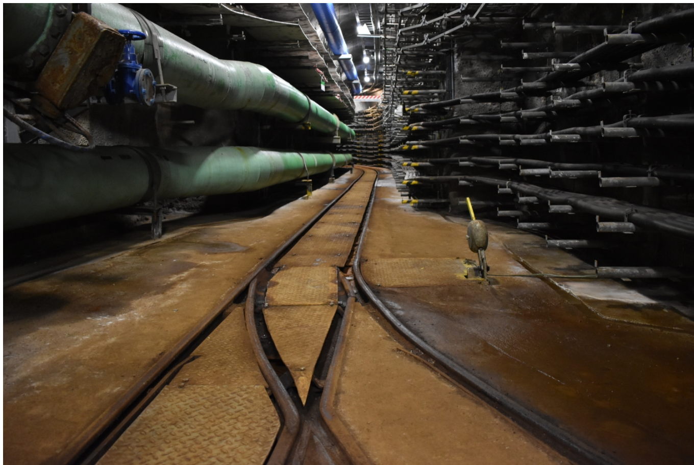
Pohled do útrob kolektoru v místě odbočky z hlavní tratě k I. P. Pavlova. (foto: Libor Hinčica)
