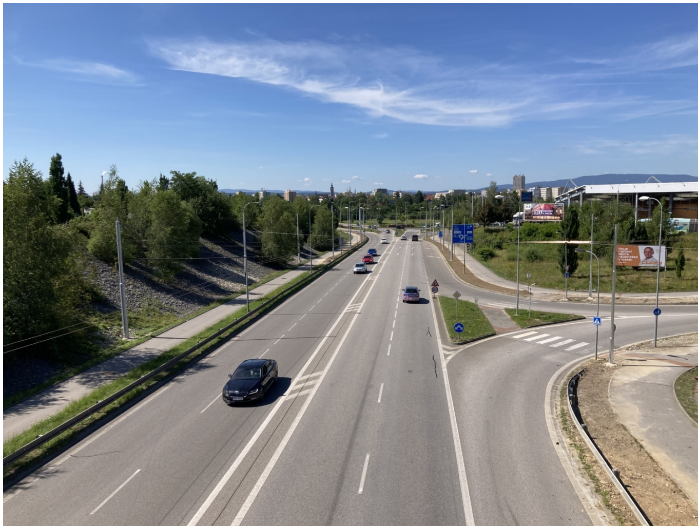
Pohled z přemostění ulice Generála Píky směrem k centru. Vpravo příjezd od vozovny.
