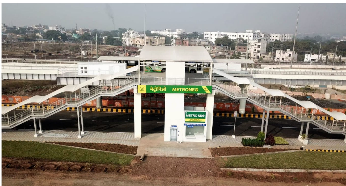
Čelní pohled. (foto: Metro Rail Today)
