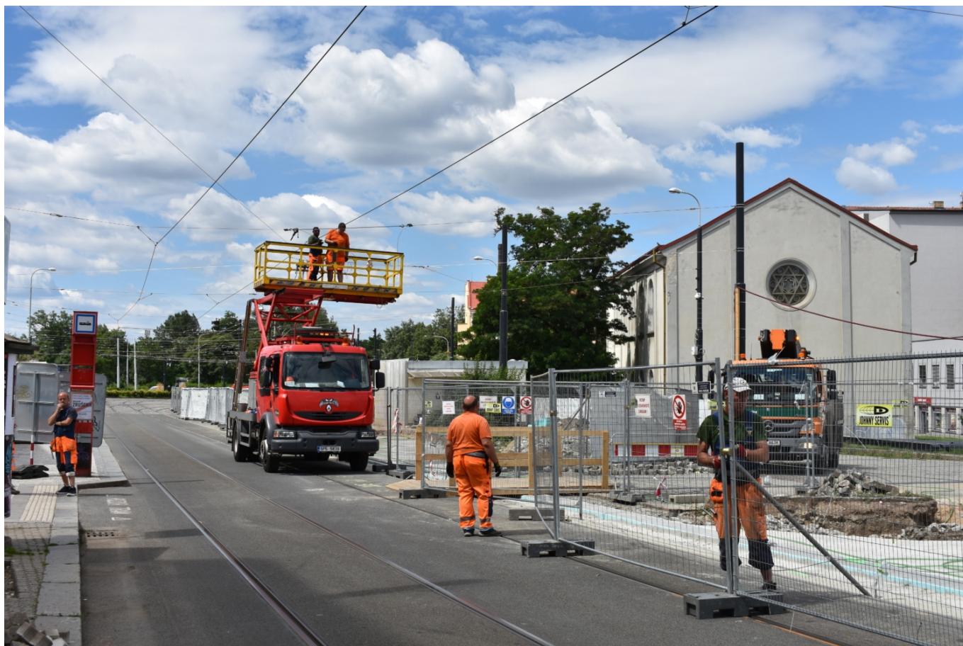
Výstavba infrastruktury v sobotu dne 16. 7. 2022 u Palmovky. napravo je k vidění budova nové libeňské synagogy, jejíž základní stavební kámen byl položen v roce 1846. (foto: Libor Hinčica)
