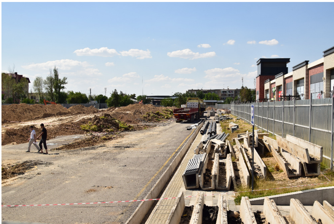
Část plochy bývalé vozovny č. 2, která ani po 6 letech od zrušení provozu zatím nemá nové využití. (foto: Petr Bystron)
