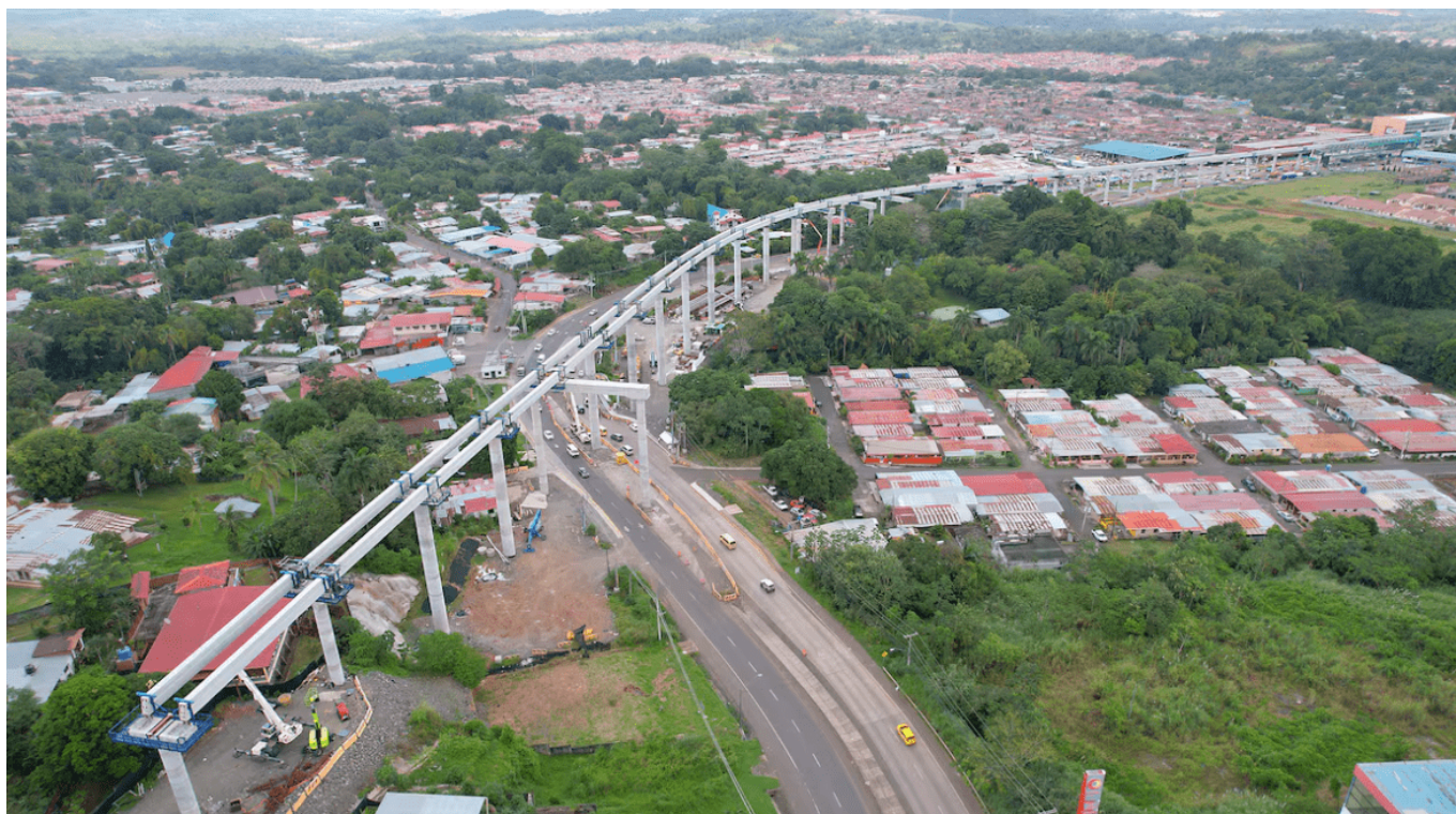
Viadukt v provincii Panamá Oeste na snímku z června 2024. (foto: Metro de Panamá)
