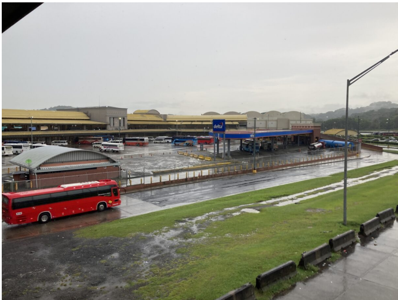
Intermodální terminál Albright, jehož součástí je největší autobusové nádraží v zemi. Právě u něj se budou stýkat linky č. 1 a 3 panamského metra. Foceno z přechodové nadzemní lávky, která je také zobrazena na snímku níže, směrem ke koncové stanici linky metra č. 1. (foto: autor)
