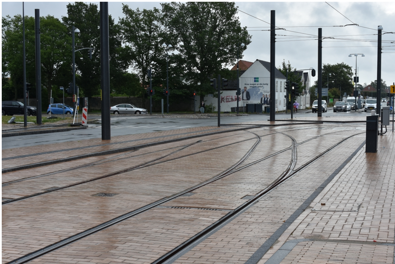
Část jednoho ze dvou připravených kolejových trojúhelníků, který by měl posloužit pro odbočení druhé tramvajové linky. (foto: Libor Hinčica)
